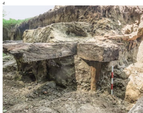
Abb. 3 Balkenrost und die darübergelegene Sandschicht mit Sandsteinresten. Gegen Nordosten.
