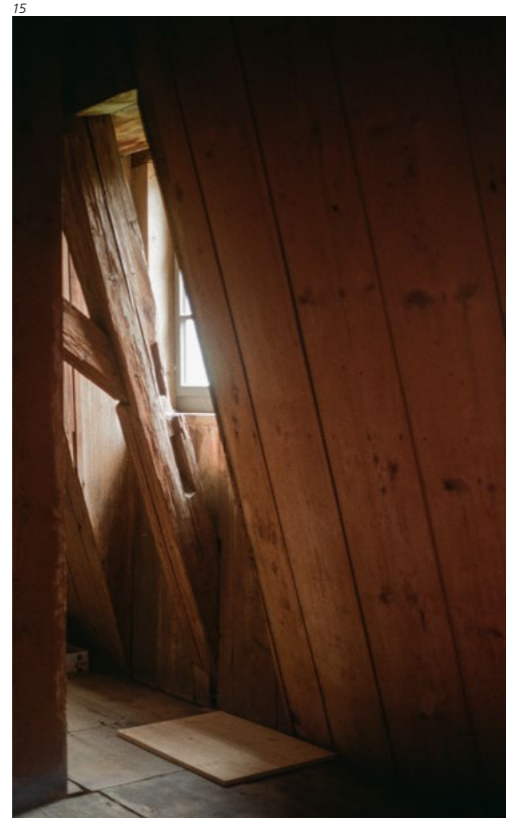
Abb. 16 Während die Winterfenster des Erdgeschosses auf die freigelegten Kalksteingewände angeschlagen sind, wurden die Fensterrahmen des Obergeschosses in den neuen Schindelschirm eingebunden. Foto 2023.
