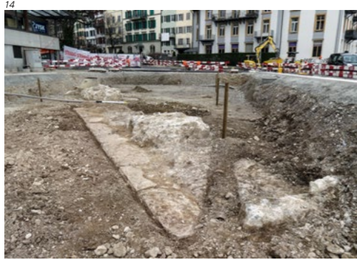
Abb. 14 Solothurn / Postplatz. 10 Meter langer Abschnitt der Frontmauer der St.-Georgs- Bastion. Gegen Nordosten.
