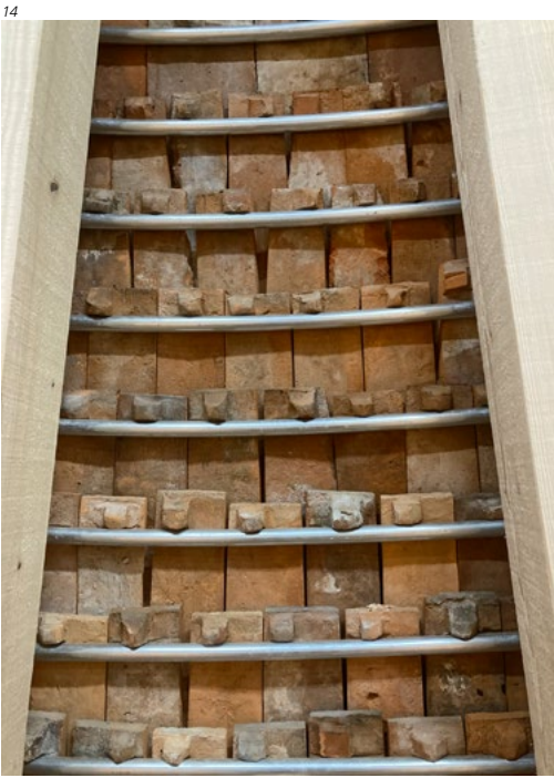
Abb. 13 Neue Ziegellattung aus Stahlrohren im Bereich des Chorraunds.
