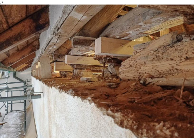
Abb. 12 Geflickter Dachfuss im Bereich westlich des Turms. Die Mauerbalken wurden ersetzt, Bundbalkenköpfe und Sparrenfüsse mit gesundem Holz angestückt.
