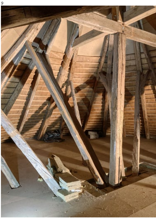
Abb. 9 Dachkonstruktion über der Apsis vor der statischen Ertüchtigung. Die zu schwach dimensionierten Radialsparren wurden durch improvisierte Streben zusätzlich gestützt.
