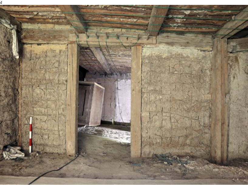
Abb. 4 Gretzenbach, Teufenthal 1. Wohnteil, Obergeschoss. Südöstliche Kammer. Fach- werkwand mit eingedrücktem Quader- oder Backsteinmuster. Blick nach Norden. Foto 2021.
