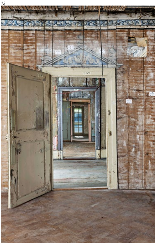
Abb. 13 Blick durch die Enfilade vom südwestlichen Eckzimmer aus. Tür mit Supraporten-Malerei von 1680. Zustand nach den Demontagearbeiten. Foto 2014.
