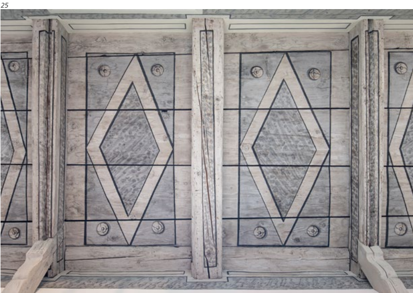
Abb. 25 Detail der bemalten Balkendecke im Längskorridor im Obergeschoss. Die Balkenunterseiten zeigen helle, grau marmorierte Füllungen. Die Bohlenbretter sind mit hellen, blaugrauen Füllungen mit marmorierten Rautenfeldern dekoriert.
