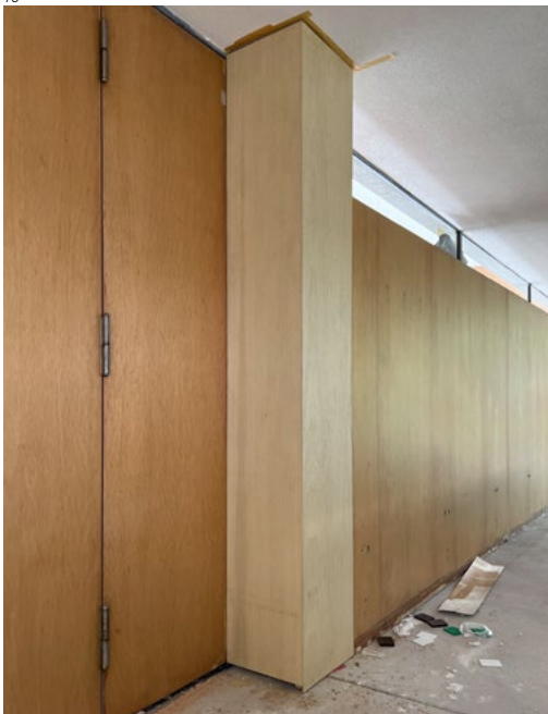
Abb. 16 und 17 Beispiel für ein erneuertes Element der hölzernen Wand- verkleidung im Klassentrakt vor und nach den Farbtuschen.
