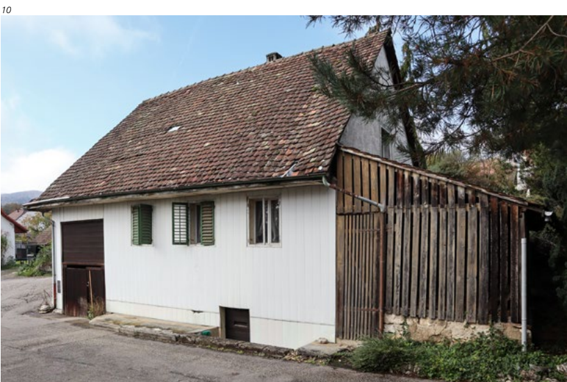
Abb. 10 Rickenbach, Belchenstrasse 6. Gesamtansicht von Südosten. Die Fassade ist mit einem jüngeren Metalltäfer verkleidet. Foto 2022.
