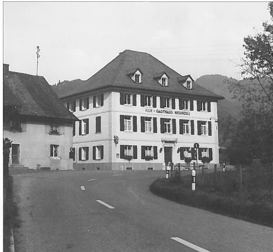
Abb. 5 Ansicht der Südfassade nach der Restaurierung von 1994. Die Lukarnen auf dem Dach sind neu hinzugekommen.
