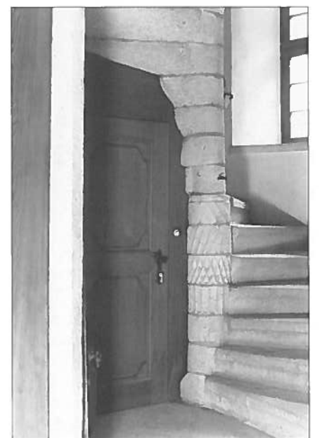
Abb. 7 Detail im Innern des Treppenturms: verzierte Spindel.
