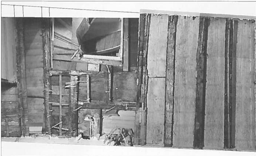
Abb. 5 Die Balkenlage über dem ersten Obergeschoss, Bestandesaufnahme, Fotomontage.
