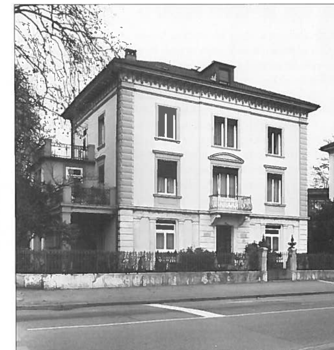
Abb. 5 Bielstrasse 12, nach der Aussenrenovation, 1995.
