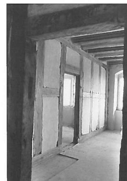
Abb. 7 Zimmertrennwand im ersten Stock nach der Freilegung, während der Renovation.
