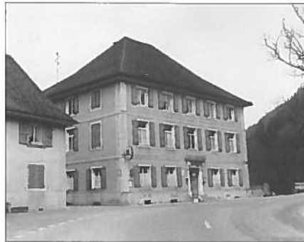
Abb. 4 Zustand vor der Restaurierung.
