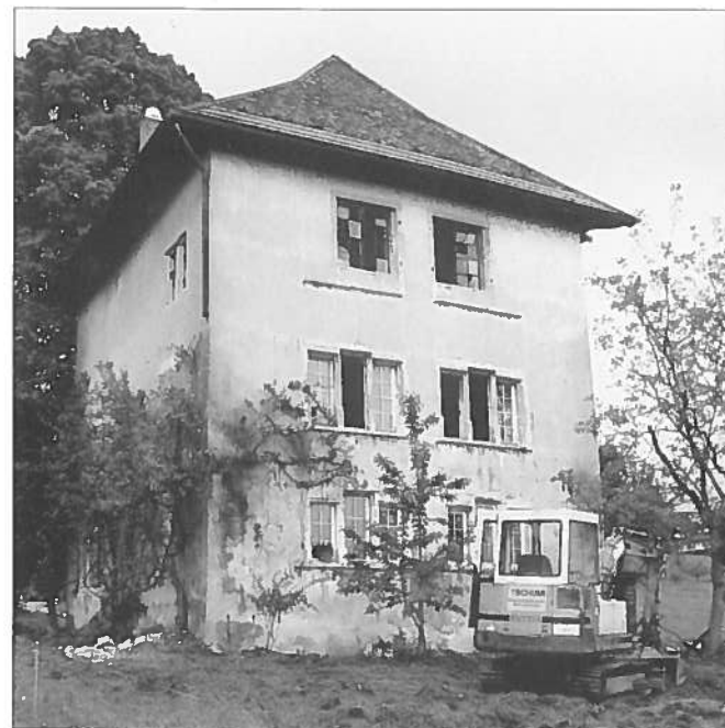
Abb. 1 Der «Waldturm» unmittelbar vor Umbaubeginn...
