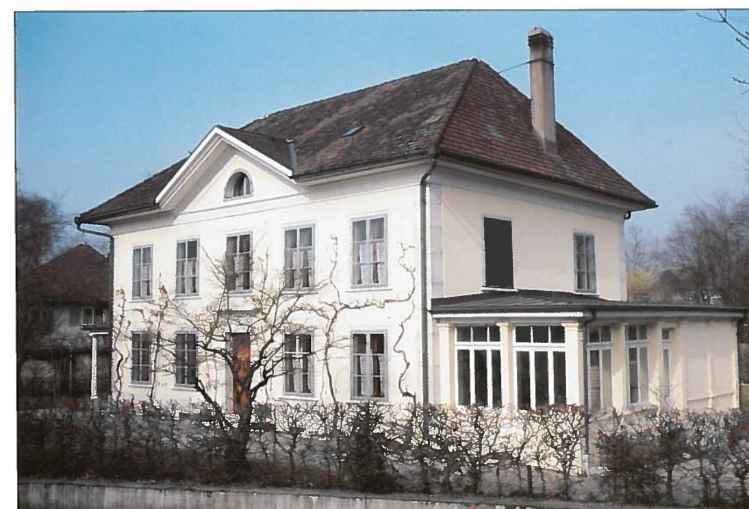
Abb. 3 Das Haus St-Niklaus-Strasse 15 von 1840, nach der Fassadenrenovation von 1994.
