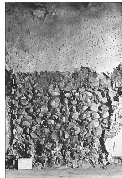
Abb. 4 Das mittelalterliche Bollenstein-Mauerwerk der Bauphase II im Bereich des zweiten Obergeschosses. Die abgeplatzten Steinköpfe entstanden durch Brandschädigung.
