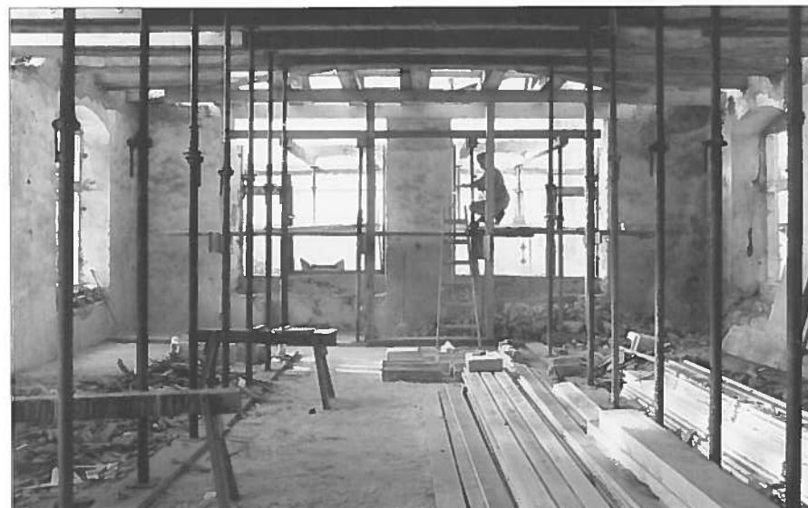
Abb. 10 ...während den Renovationsarbeiten...
