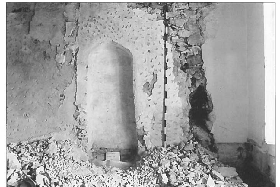
Abb. 5 3. Obergeschoss: Der ehemalige Durchgang, der trotz mehrmaligen baulichen Veränderungen die Lage des einstigen hölzernen Wehrgangs widerspiegelt. Im markanten Mauerriss rechts liess sich das Negativ des inneren Mauermantels der 1782 abgebrochenen mittelalterlichen Stadtmauer fassen.
