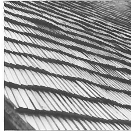
Dachdeckerarbeiten: Kurt Weber, Subingen
