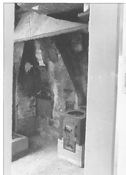
Abb. 4 Erdgeschoss, Heizstelle für den Kachelofen und Sparherd, aus der Zeit um 1870.
