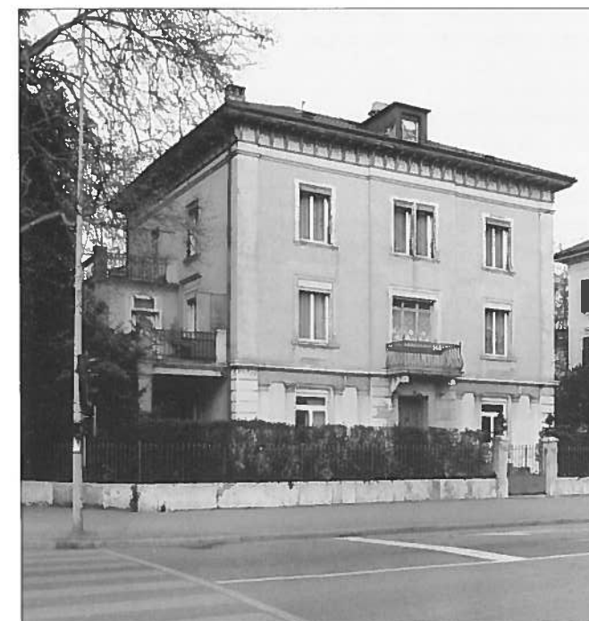
Abb. 4 Bielstrasse 12, vor der Aussenrenovation, 1988.
