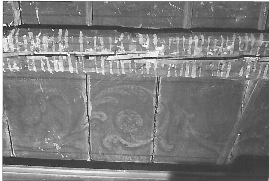
Abb. 2 In der Stube im Erdgeschoss kam eine mehrfarbig bemalte Balkendecke zum Vorschein. Sie wurde nicht restauriert, sondern mit einer neuen Decke wieder verschalt.
