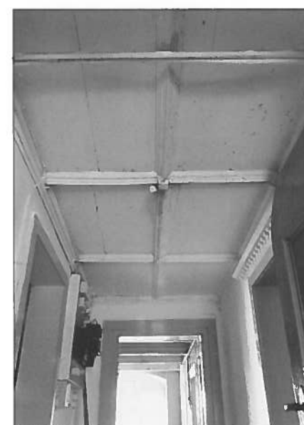
Abb. 6 Korridor im Erdgeschoss, Felderdecke vor der Renovation.
