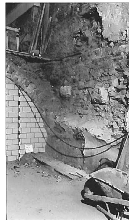
Abb. 6 Keller, Südwand. Beim Teilabbruch des Kellergewölbes im Jahre 1994 kam eine ältere Kellerwand mit regelmässig gesetzten Konsolen zum Vorschein. Der verwendete Mauermörtel zur nachträglich unter das Brandmauerfundament gebauten Kellerwand ist identisch mit demjenigen, der beim Einsetzen der dendrochronologisch ins Jahr 1430 datierten Deckenbalken über dem zweiten Obergeschoss verwendet wurde.
