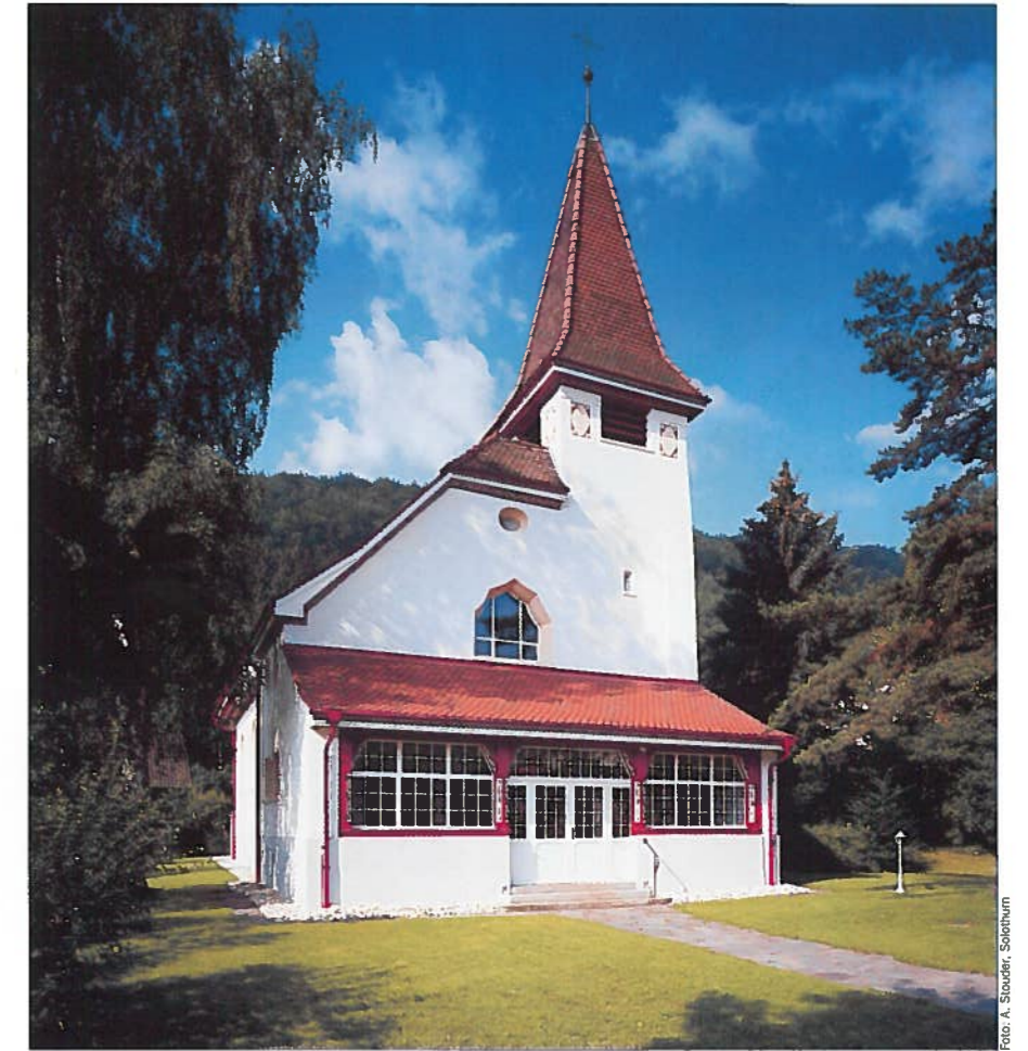
Abb. 2 Ansicht von Osten, Hauptfassade.
