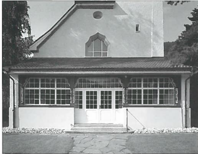
Abb. 4 Aussenansicht der Vorhalle.
