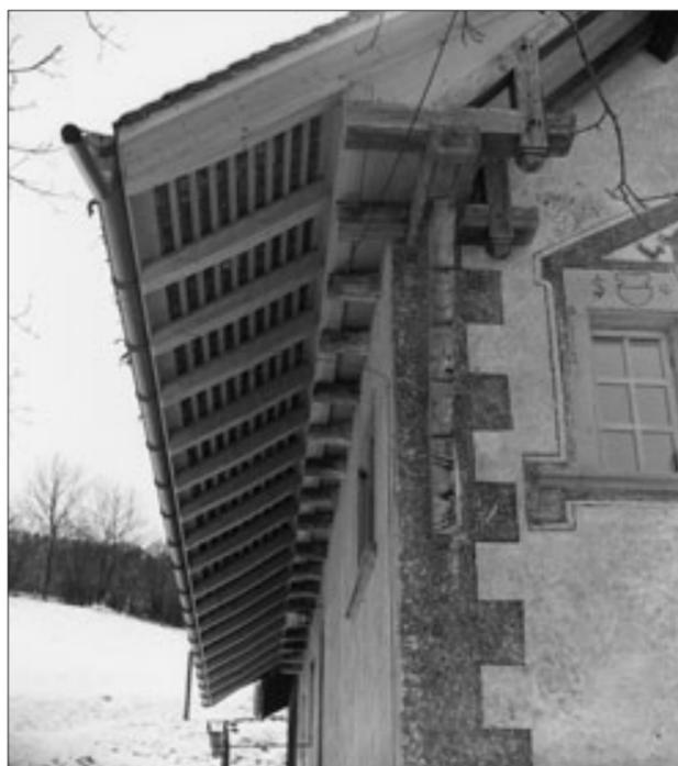
Abb. 2 Dachuntersicht mit erneuerten Aufschieblingen.
