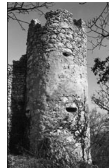
Abb. 38 Dornach, Ruine Dorneck. Südliche Schale des Doppelturms (T3), von Süden. Zustand 1989.
