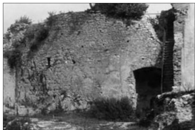
Abb. 15 Dornach, Ruine Dorneck. Innenseite (M1) des Grossen Bollwerks (B1). Zustand nach der Restaurierung von E. Probst (nach 1907/08). Im linken Bild Drittel ist das grossblockige Mauerwerk (M1a) mit der Öffnung zu erkennen, daneben in der Bildmitte der kleinsteinige Abschnitt (M1b), der damals noch zu grossen Teilen flächig von Verputz verdeckt war. Im rechten Bild Drittel sichtbar der Pulverturm (T5) und die heute noch bestehende Eisentreppe zum Grossen Bollwerk.
