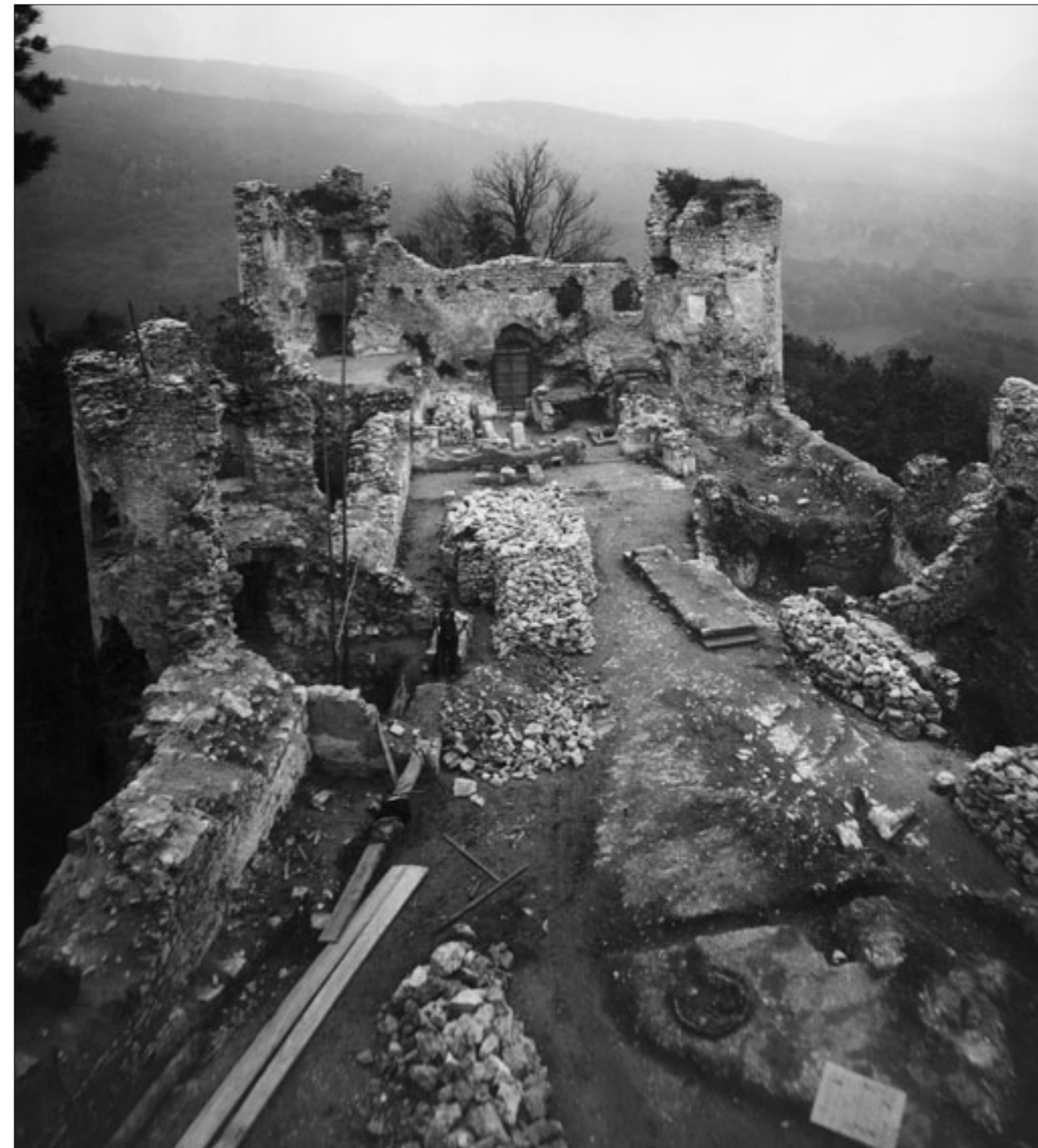
Abb. 51 Dornach, Ruine Dorneck. Unterburg, von Norden. Zustand während der Restaurierung (1904–1907/08) von E. Probst. Im Hintergrund: rechts der Hexenturm (T1) mit Hocheingang links oben, links der Doppelturn (T2/T3), zwischen den beiden Türmen der südliche Beringabschnitt (M5) der Unterburg. Vor dem Hexenturm ist der verschüttete Südkeller erkennbar.
