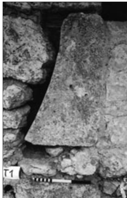
Abb. 23 Dornach, Ruine Dorneck. Spolie, in der Westleibung des Schlitzfensters auf der Südseite des Hexenturms (T1) vermauert. Zustand während der Restaurierung 1999.
