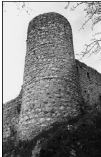
Abb. 22 Dornach, Ruine Dorneck. Hexenturm (T1), von Südwesten. Zustand 1989.
