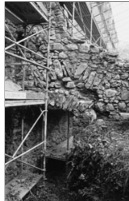
Abb. 25 Dornach, Ruine Dorneck. Südhaupt der Südmauer (M18) des Nordwestbaus. Zustand während der Restaurierung 1999. Über dem aktuellen Türsturz ist der ältere zu erkennen.
