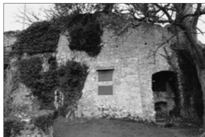
Abb. 16 Dornach, Ruine Dorneck. Innenseite (M1) des Grossen Bollwerks, Ausschnitt wie auf Abb. 15. Zustand 1998. Wenig links der stichbogig überwölbten Öffnung des Pulverturmes (T5) ist die südöstliche Ecke des kleinsteinigen Mauerwerks (M1b) zu erkennen.
