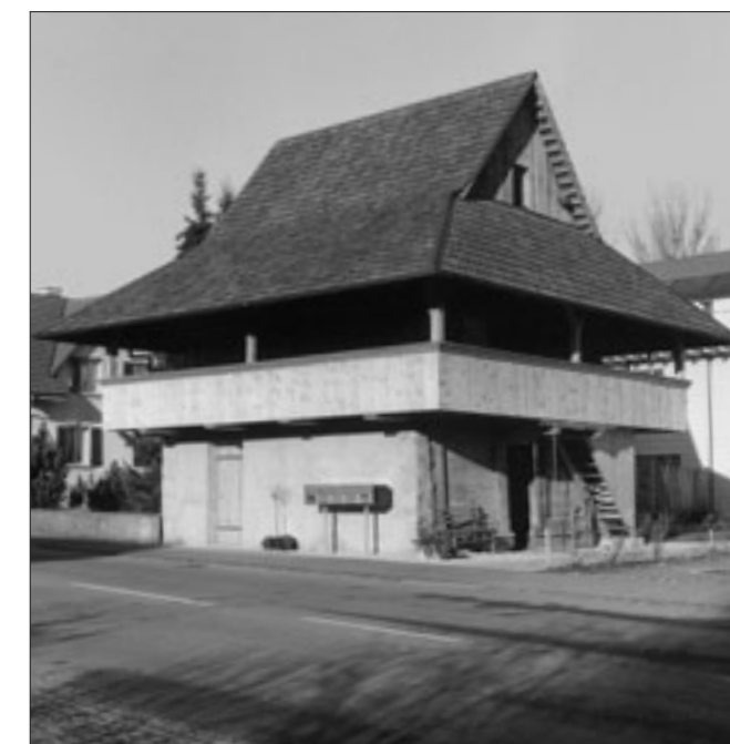
Abb. 2 Der Speicher nach der Wiederherstellung von 1997.
