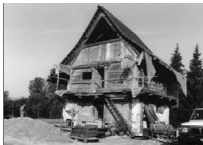
Abb. 6 Der Speicher nach der Freilegung, das heisst nach Abbruch der Anbauten von 1923.
