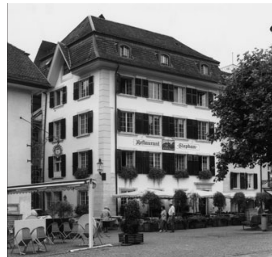
Abb. 1 Solothurn, Restaurant «Zum alten Stephan» am Friedhofplatz, nach der Fassadenrenovation von 1998.
