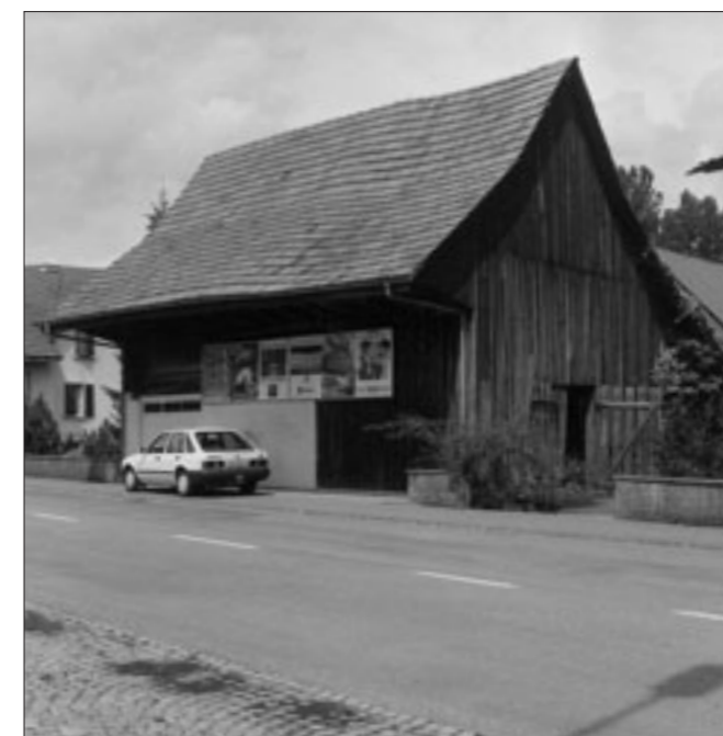
Abb. 1 Kappel, der unscheinbare Schopf an der Dorfstrasse 34 sollte abgebrochen werden.
