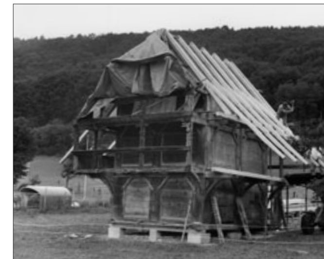
Abb. 4 Dacherneuerung am neuen Standort.
