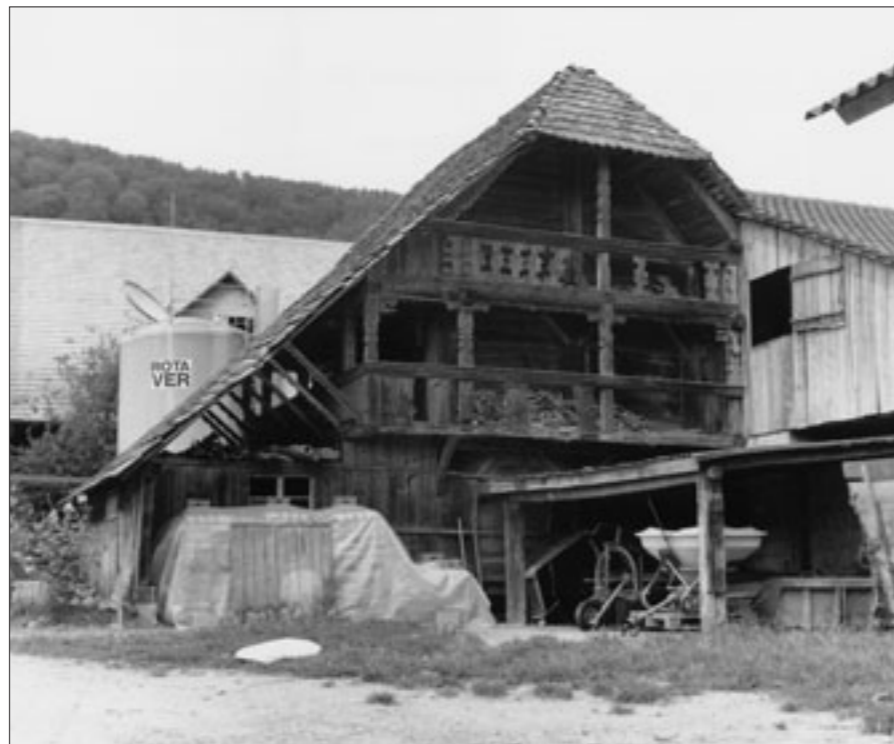
Abb. 1 Oberramsern, Speicher Wyss, Situation vor der Versetzung.
