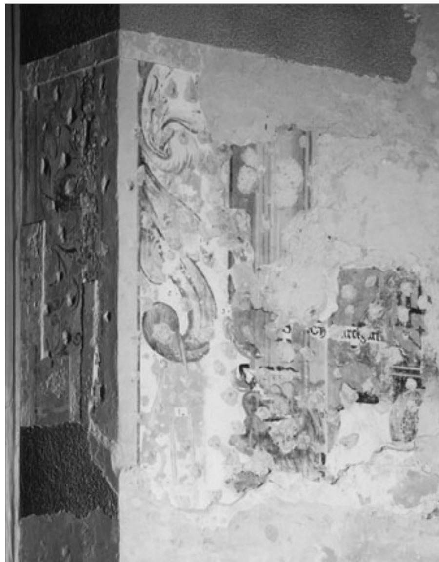
Abb. 5 Freigelegte Wandmalereien aus dem 16. und dem 17. Jahrhundert im Chor, während der Restaurierung 1998/99.
