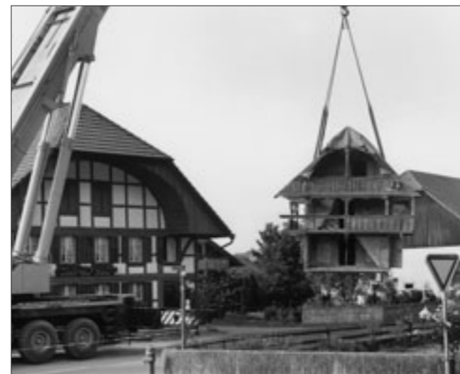
Abb. 3 Der Speicher wird am 23. Juni 1998 mit einem Pneukran versetzt.
