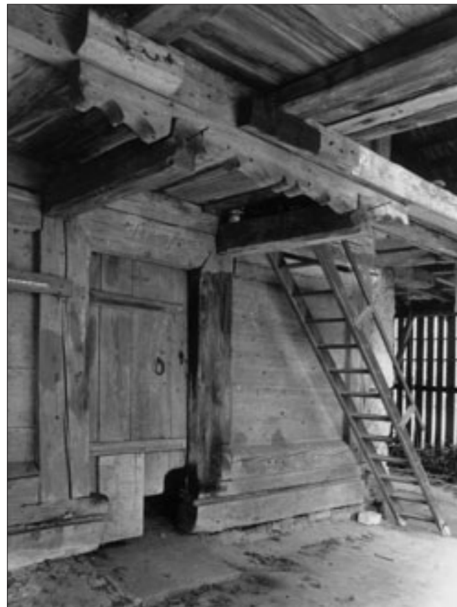
Abb. 3 Im Innern des Schopfes steckte ein unerwartet gut erhaltener Speicher von 1702.
