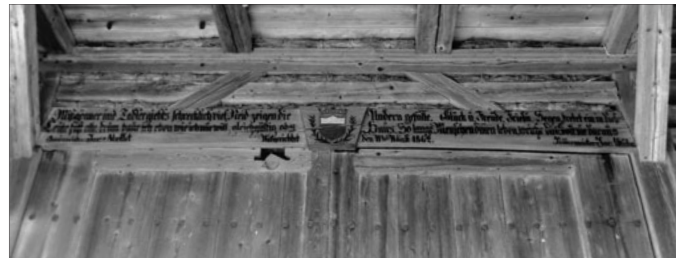
Unterramsern, Eichholz 57, Spruch auf dem Tennstorbalken nach der Restaurierung von 1998.
