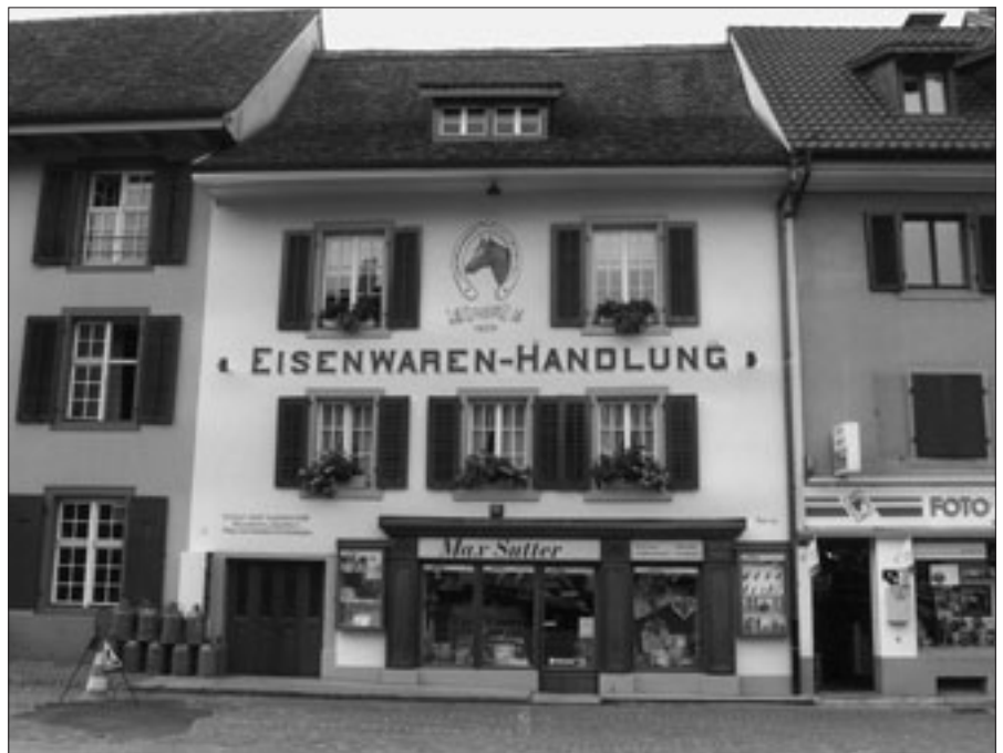
Dornachbrugg, Amthausstrasse 23, Fassade nach der Restaurierung 1998.
