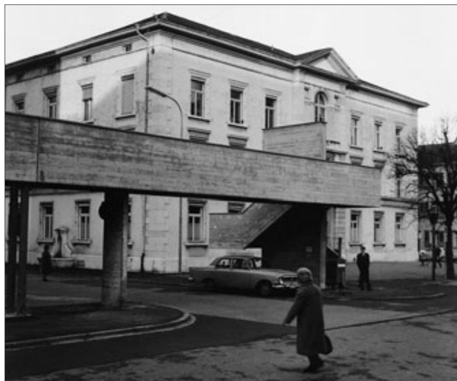
Abb. 2 Zustand 1966 nach dem Bau des Stadthauses.
