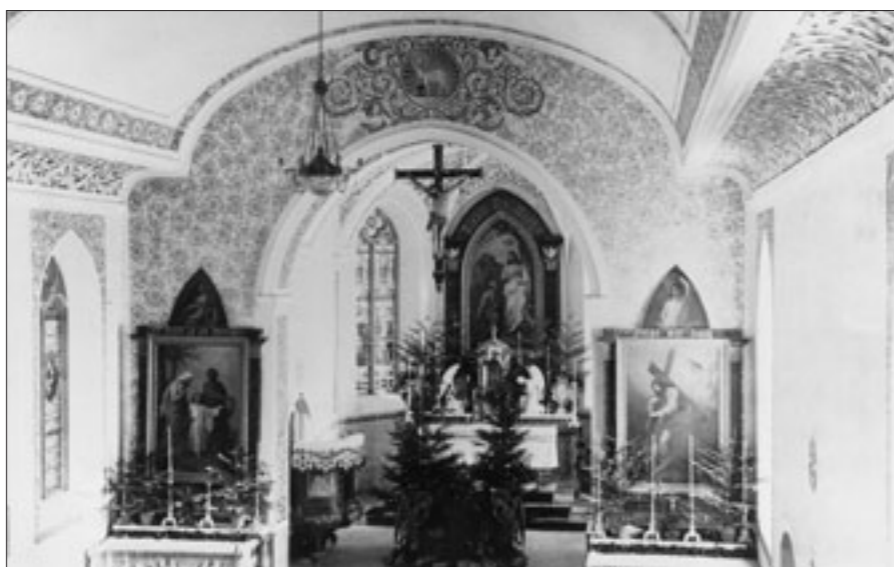
Abb. 2 Innenraum gegen Osten mit neugotischer Ausstattung, alte Fotografie, vor 1913.
