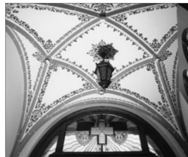
Abb. 4 Gewölbe der Eingangshalle mit schwarzen Schablonenmalereien auf weissem Grund, nach der Restaurierung von 1998.
