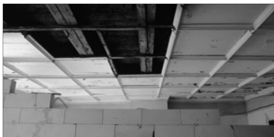
Abb. 2 Die Decke über dem ehemaligen Saal im zweiten Obergeschoss, Blick nach Westen. Zustand nach dem Entfernen einzelner Tafeln, 1980.
