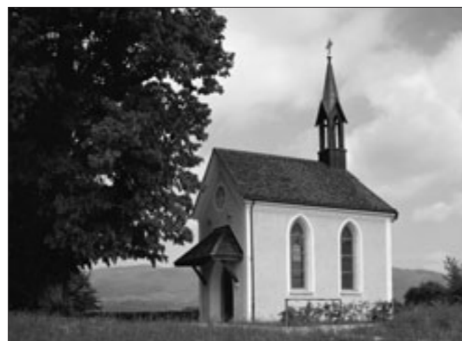
Abb. 2 Ansicht von Südwesten, nach der Restaurierung 1994–1998.
