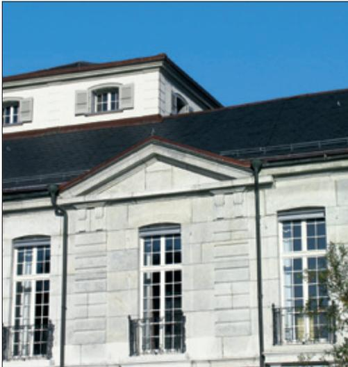
in das offenbar aufgrund einer Fehlkonstruktion immer wieder Wasser eindrang, bereits reparaturbedürftig. Bei den 1717/18 ausgeführten Korrekturen im Dachstuhlbereich wurde eine ursprünglich über der Südfassade platzierte Dachbalustrade entfernt (vgl. Abb. 141).
