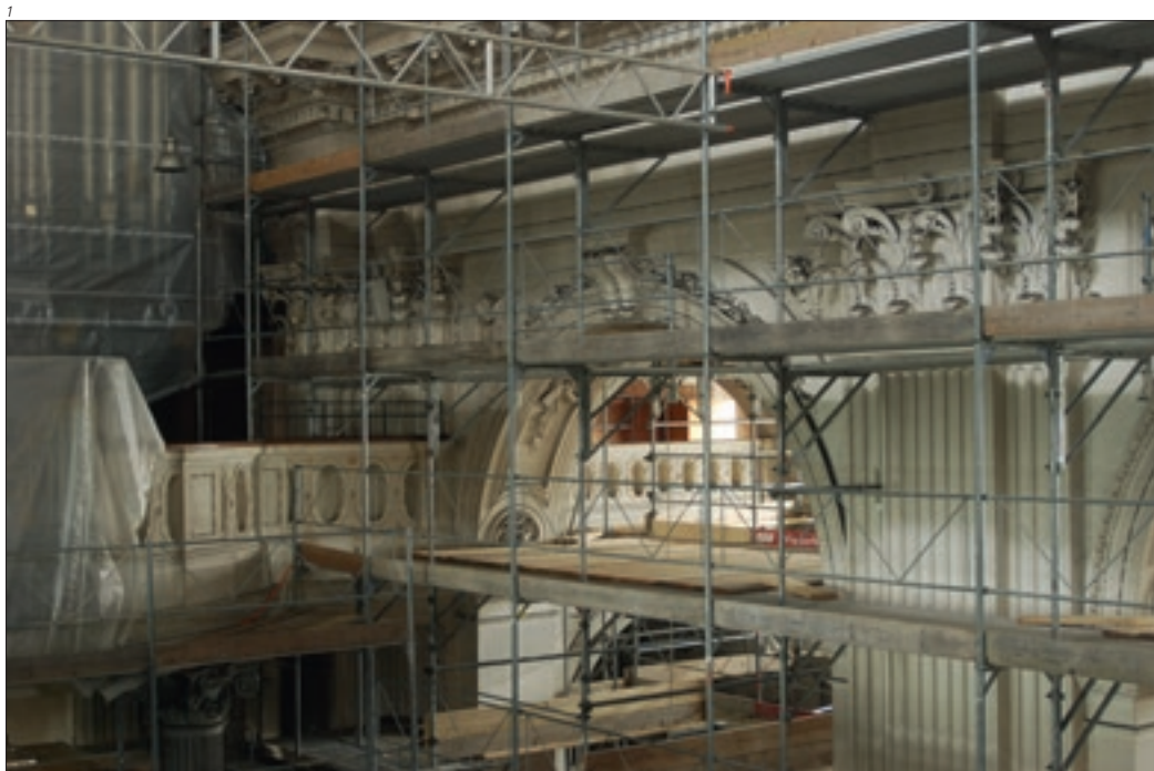
Abb. 1 Im Juli 2011 war der Innenraum der Kathedrale vollständig eingerüstet. Blick auf Orgelempore und nordwestlichste Arkade des Mittelschiffs.
