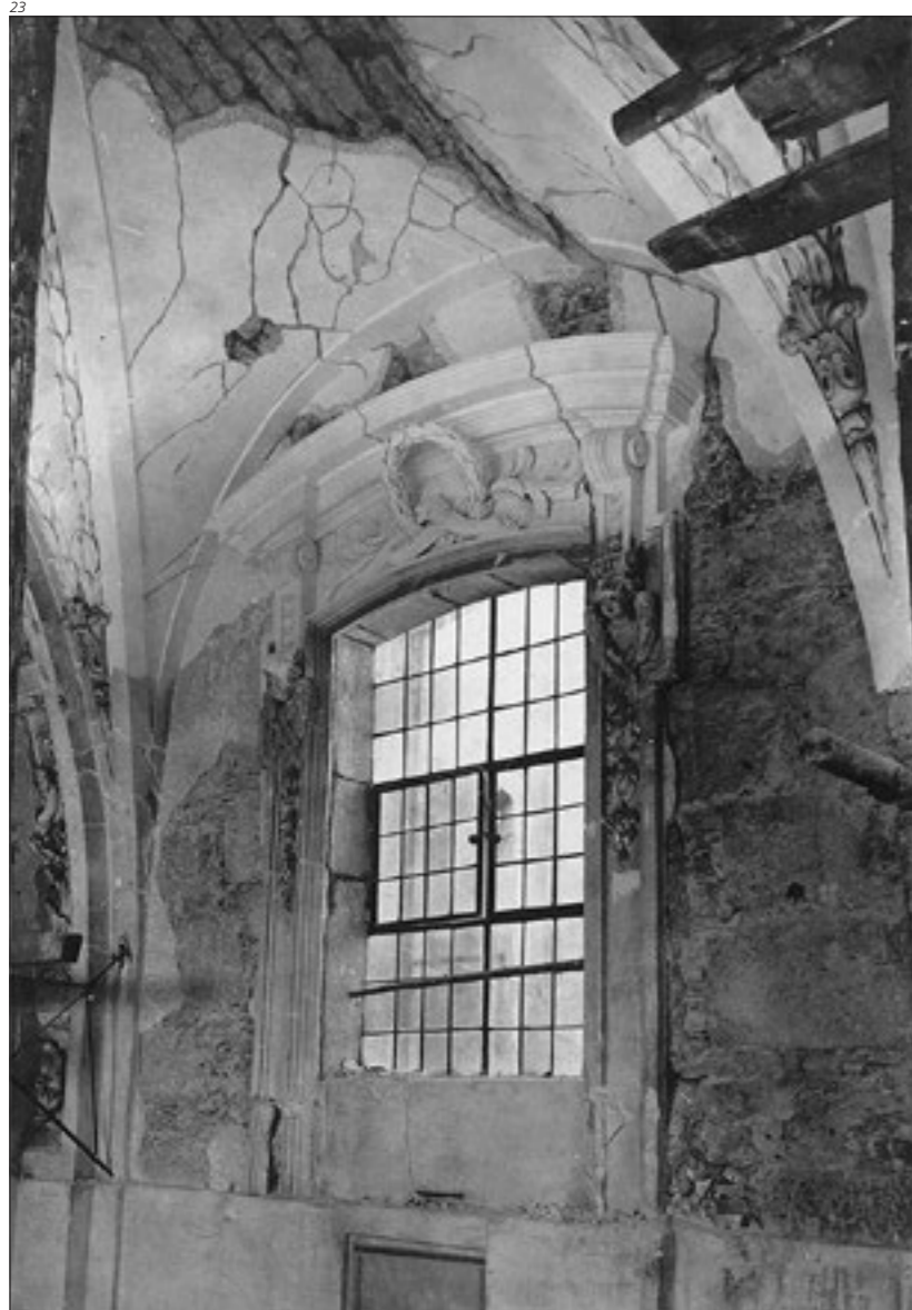
Abb. 23 Querschiff, Obergadenfenster. Zustand während der Restaurierung mit abgeschlagenen Stuckflächen. Foto: Hans König (Fotomappe 1917–1937, DSSO 709, 5.1).
