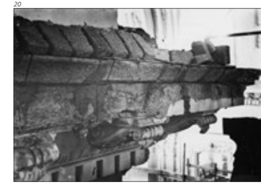
Abb. 20 Das Kranzgesims während der Restaurierung 1917/18, mit bereitgelegten vorgeformten Würfeln und Armierung am Gesims. Foto: Hans König (KDSO).
