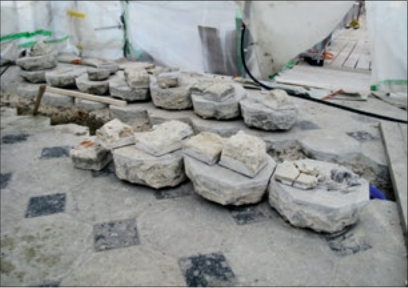
Abb. 70 Chorboden während des Rückbaus der Bodenerhöhung von 1970. Im Vordergrund der sehr gut erhaltene originale Boden mit schwarz bemalten Quadraten.
