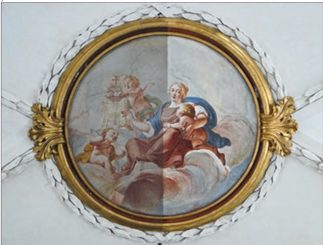
Abb. 9 Deckenbild im Mittelschiff mit Darstellung der «Liebe». Zustand während der Restaurierung, die rechte Hälfte ist gereinigt, die linke ungereinigt.
