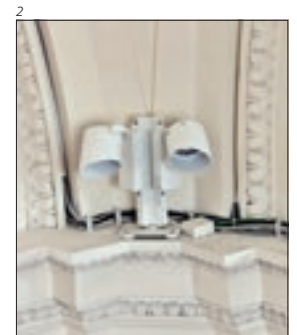
Abb. 1–3 Viele elektrische Installationen sind – von unten unsichtbar – auf den Gesimsen montiert. Über dem Kranzgesims verläuft die horizontale Verteilung offen.
