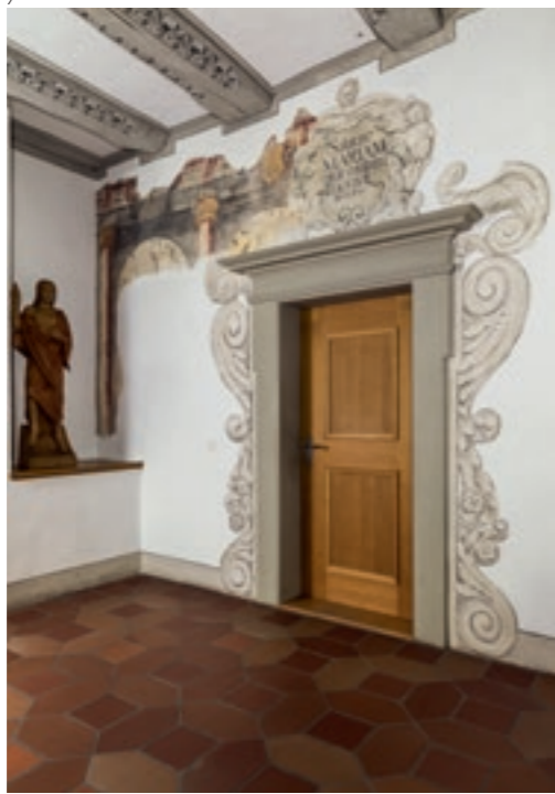
Abb. 7 Glutzbau. Eingang zur Reichensteinkapelle mit Resten von Wandmalereien aus der Zeit um 1600 (links) und um 1700 (Portaleinfassung).
