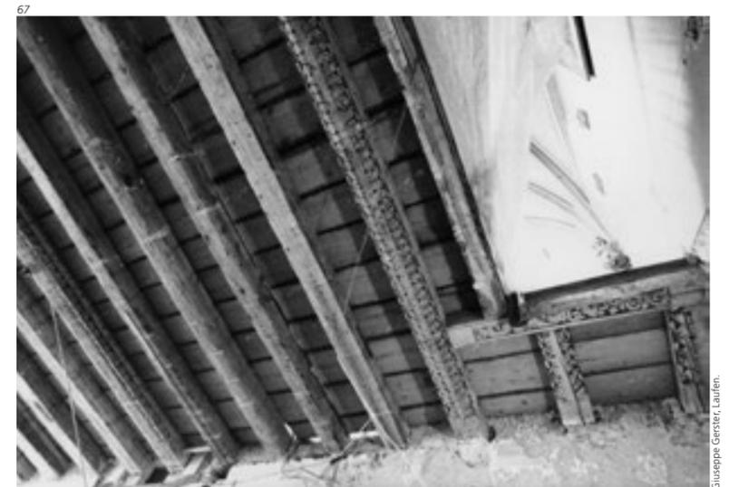
Abb. 68 und 69 Balkendecke wie in Abb. 66, während der Restaurierung 1983–1986. Auf den Balken ist teilweise die zarte Marmorierung zu erkennen. Die Malerschicht zwischen den Balken war vom Grundputz aus Lehm und Stroh auf die darunterliegende Gipsdecke abgefallen. Fotos 1983.
