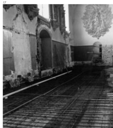
bereits bekannte, in unregelmässigen Bahnen verlegte Kalksteinboden aus den verschiedenen Bauzeiten zum Vorschein. Er wurde zusammen mit den neubarocken Fliesen entfernt. Der neue Boden besteht wie der ursprüngliche aus Jurakalksteinplatten, deren Oberfläche genadelt wurde.
