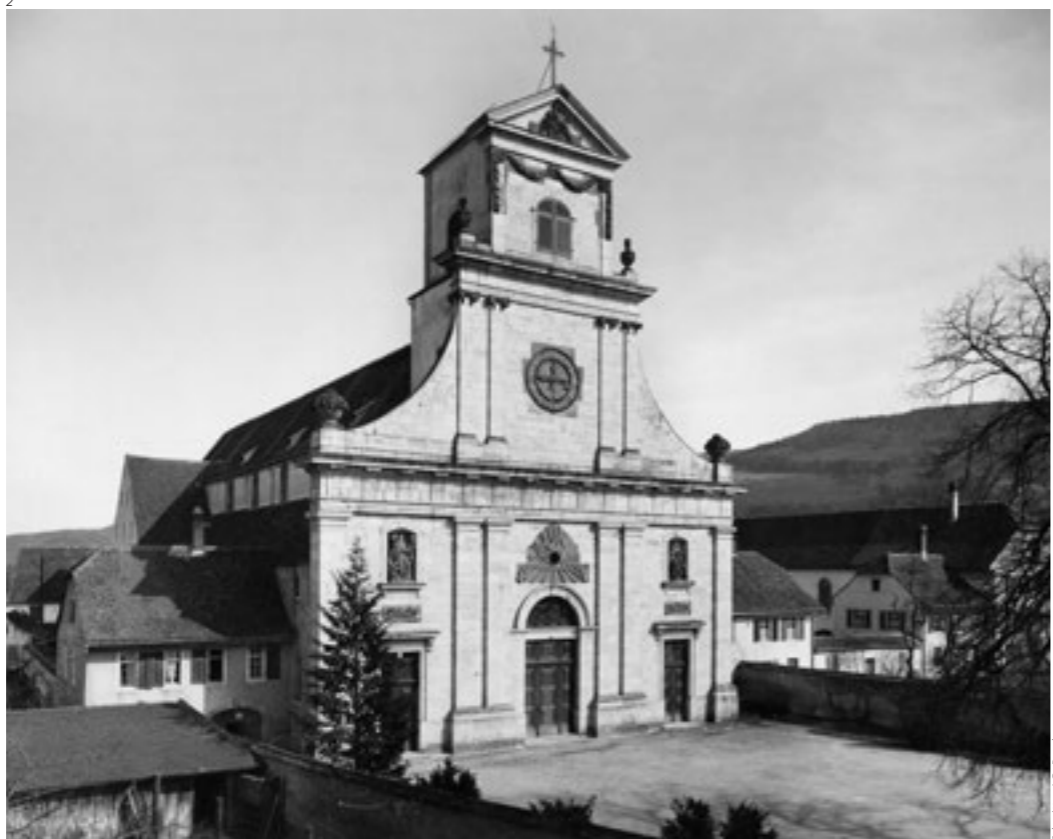
Abb. 2 Klosterkirche, Fassade vor der Restaurierung von 1972/73. Die roten Sandsteinquader sind ungefasst und heben sich deutlich vom hellen Inzlinger Stein ab.
