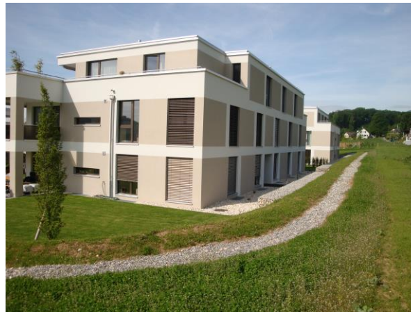
Erdwall mit Drainage
