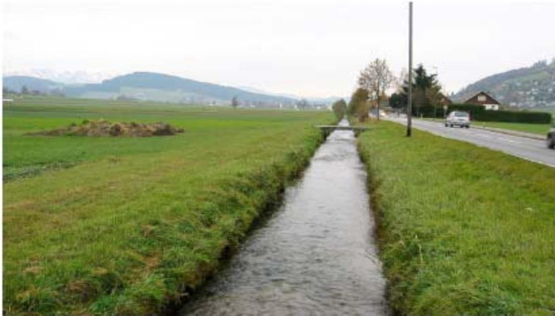
Abb. 27: bestehender Chiselauf, schnurgerader Kanal ohne Bestockung, Ufer mit Brettern gesichert
