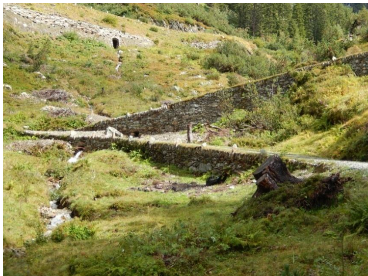
Abbildung 7: Im Sommer 2013 durch Strassenbau-Lehrlinge restaurierte Trockenstützmauern an der alten Sustenstrasse von 1811. Foto Eneas Domeniconi, Juli 2013
