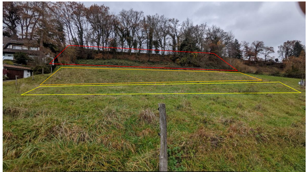
Abb. 2: Blick nach Norden auf den ehemaligen Ein- schussbereich. Gliederung der Schiessanlage: Gelb: Zeigergraben, orange: Kugelfanwall, rot: Einschussbereich Feldschiessen. Foto: magma AG, 26.11.2021
