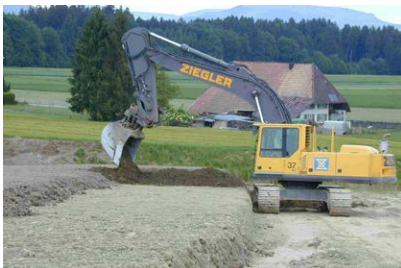
Bagger beim Rektivieren: Auftragen des Oberbodens auf den Unterboden
