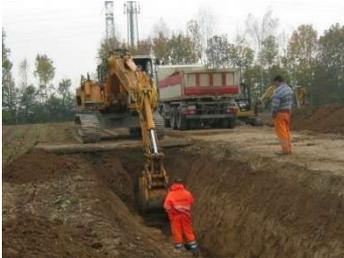
Bagger und Transportfahrzeuge stehen immer auf der Rohplanie; der neu angelegte Boden wird nicht befahren. Der Auftrag des Unter- resp. Oberbodens erfolgt mit Bagger in einem Arbeitsgang; der Boden wird locker geschüttet. Die Oberfläche wird mit der angestellten Schaufel ausgeebnet und darf weder Mulden noch Schmierschichten aufweisen. Bei flächigen Rekultivierungen wird wenn immer möglich im Streifenverfahren gearbeitet.
