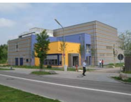
Abb. 3: Geothermie Kraftwerk Unterhaching Südbayern
