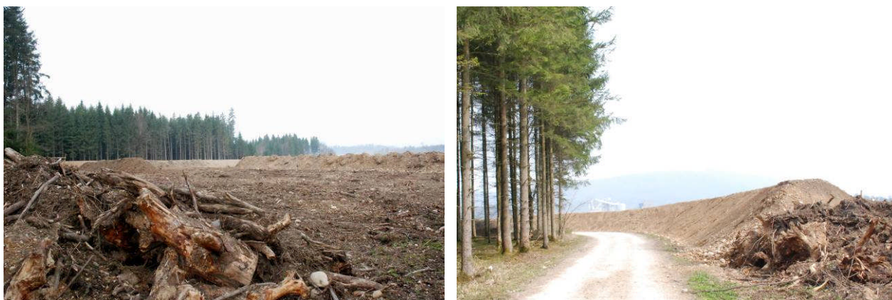
Abbildung 9: Fachgerechter Umgang mit Boden im Abbauggebiet Ischlag - Dreiangel (Boningen): links die Situation kurz nach erfolgter Rodung, rechts ein Unterbodendepot.
