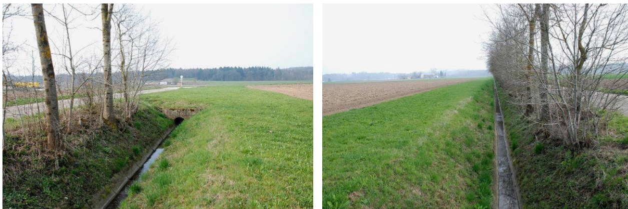
Abbildung 20: Der Hardgraben beim Austritt aus dem eingedolten Bereich und der weitere Verlauf des Gewässers in einer Betonhalbschale (Aufnahmestandort östlich der Kantonsstrasse Härkingen - Fulenbach; links Blick Richtung SW, rechts Blick Richtung NE)
