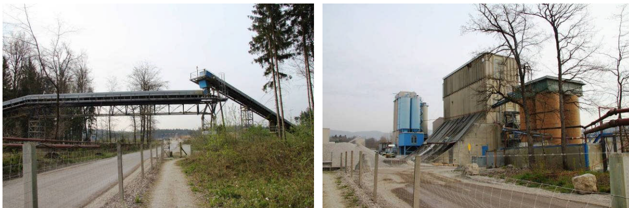
Abbildung 6: Kiestransport von der Abbaustelle per Förderband (links) zur Verarbeitung ins Beton- und Kieswerk (rechts) in Gunzgen
