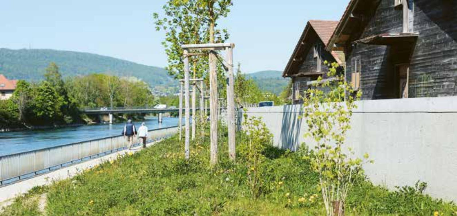
***Auf dem ehemaligen Bally-Areal in Schönenwerd (Foto oben) reichen gewerblich genutzte Bauten und Anlagen sowie Denkmäler der Industriegeschichte so nahe an den Flusslauf, dass ein angemessener Hochwasserschutz nur durch harte Massnahmen, in diesem Fall durch den Bau von Schutzmauern, möglich ist. Dafür musste eine lückenhaft gewordene Platanenreihe weichen, konnte aber durch eine durchgehende Reihe heimischer Spitzahorne ersetzt werden.***
