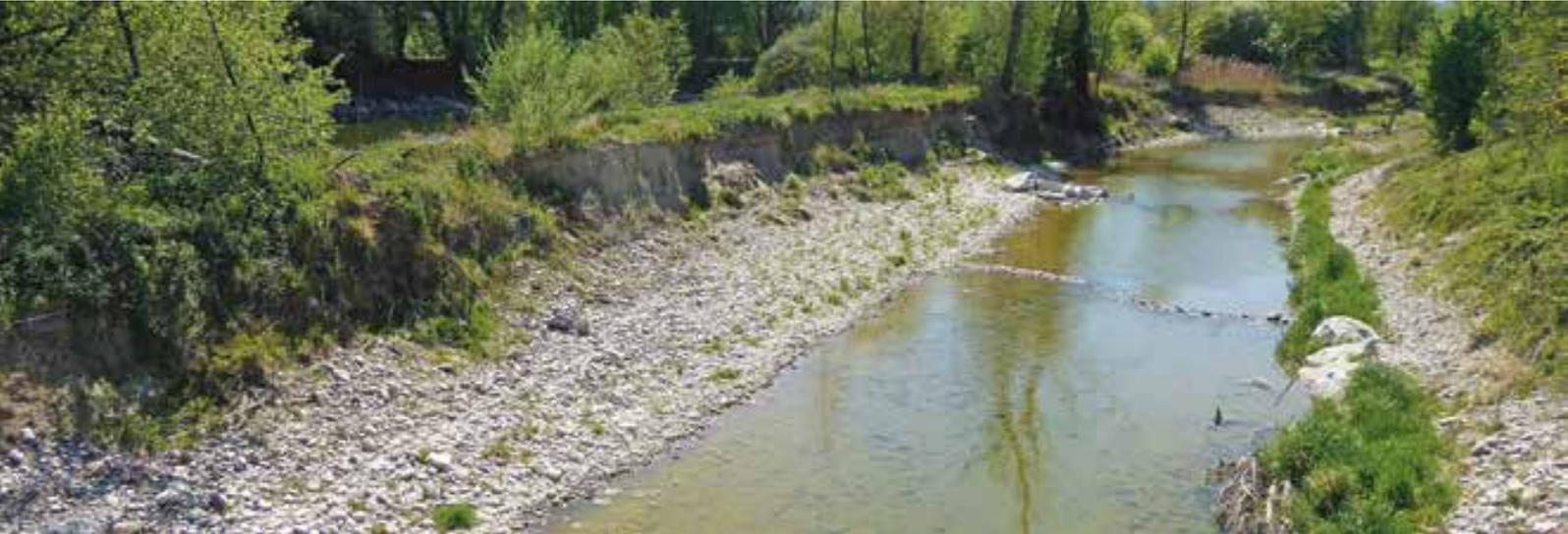
**Dort, wo einst die «Ballyschwelle» (Foto unten) das Wasser staute und die Fischwanderung behinderte, verbreitern heute Seitengerinne den Altlauf der Aare (Fotos oben und Seite rechts). Durch den Rückbau der betonierten Schwellenplatten senkte sich flussaufwärts der Wasserspiegel um mehr als einen Meter. Um auch den einmündenden Gretzenbach (Grafik unten) fischgängig anzubinden, wurde dessen Becken-Riegelrampe durch drei neue Becken ergänzt.**
