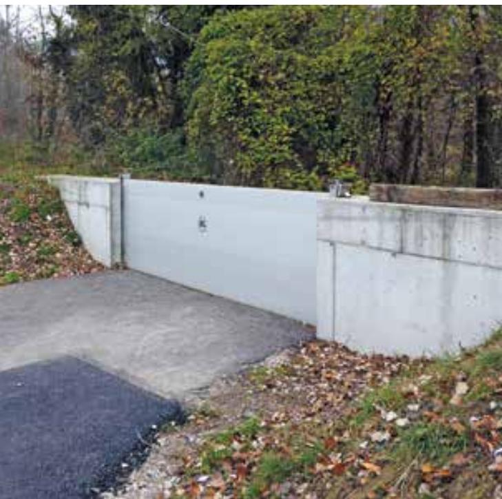
Um das angestrebte Sicherheitsniveau auch in diesen Bereichen zu erreichen, musste dort die Uferlinie durch **Schutzbauwerke** angehoben werden. Sie sind verhältnismässig nahe am Gerinne angelegt, wobei die Wahl der Massnahme und deren Ausbautart abhängig ist von den räumlichen Gegebenheiten:
