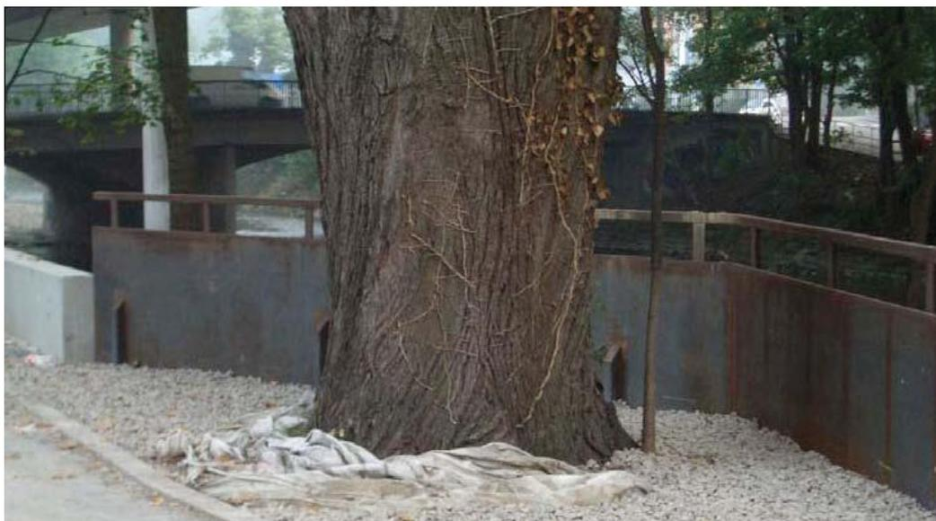
**Abb. 6.28:** Hochwasserschutzmauer mit Stahlplatten (lokal um Bäume), Lagerung mit Punktfundamenten.
