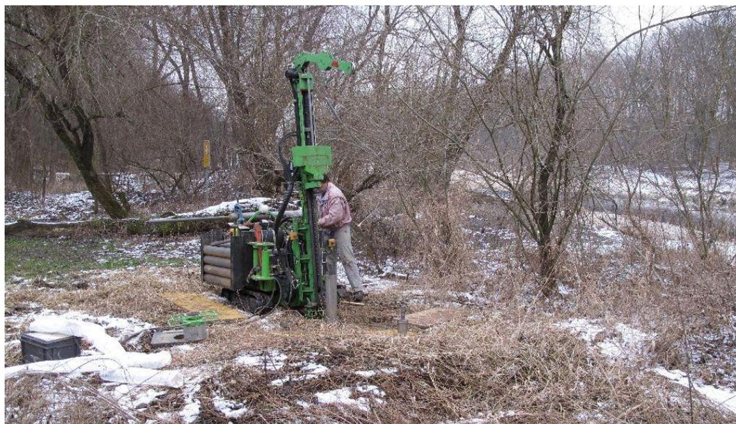
**Abb. 7.1:** Verrohrte Rammkernbohrung in Arbeit.
