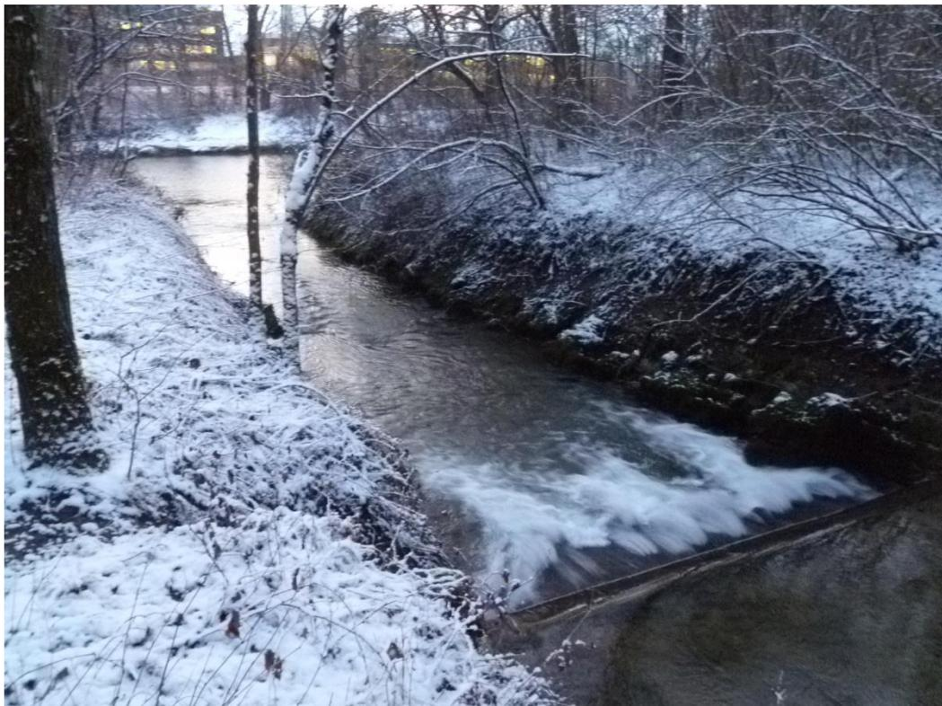
**Abb. 6.20:** Mündung Stegbach, oberste der drei Schwellen ( $\Delta h = \text{ca. } 0.8 \text{ m}$ )
