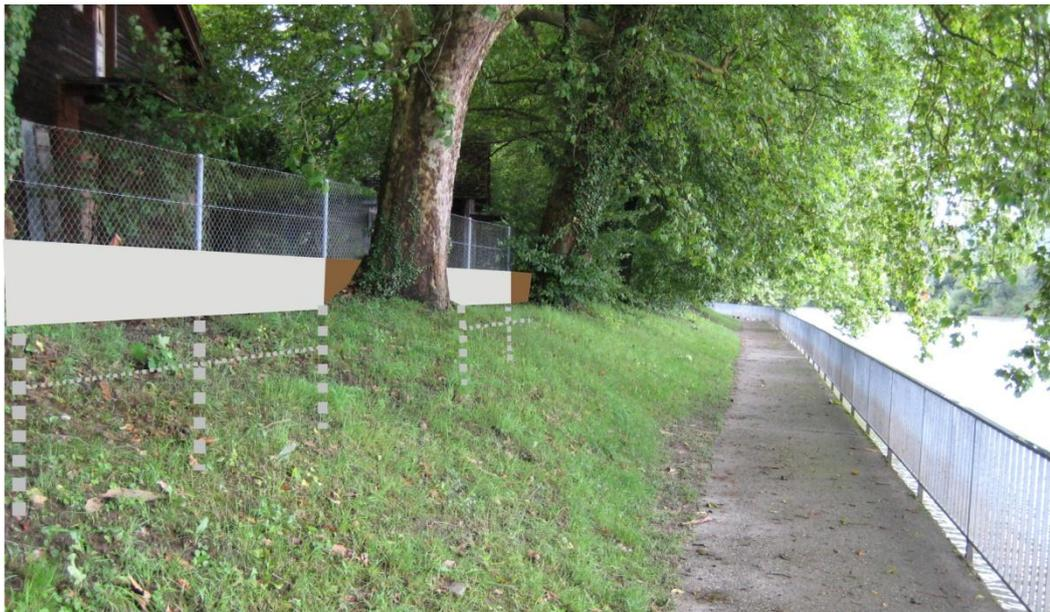
**Abb. 6.27:** Fussweg entlang der Aare, Blick gegen die Fliessrichtung. Hochwasserschutzmauer aus Beton, im Nahbereich von Bäumen erfolgt die Lagerung auf Punktfundamenten.
