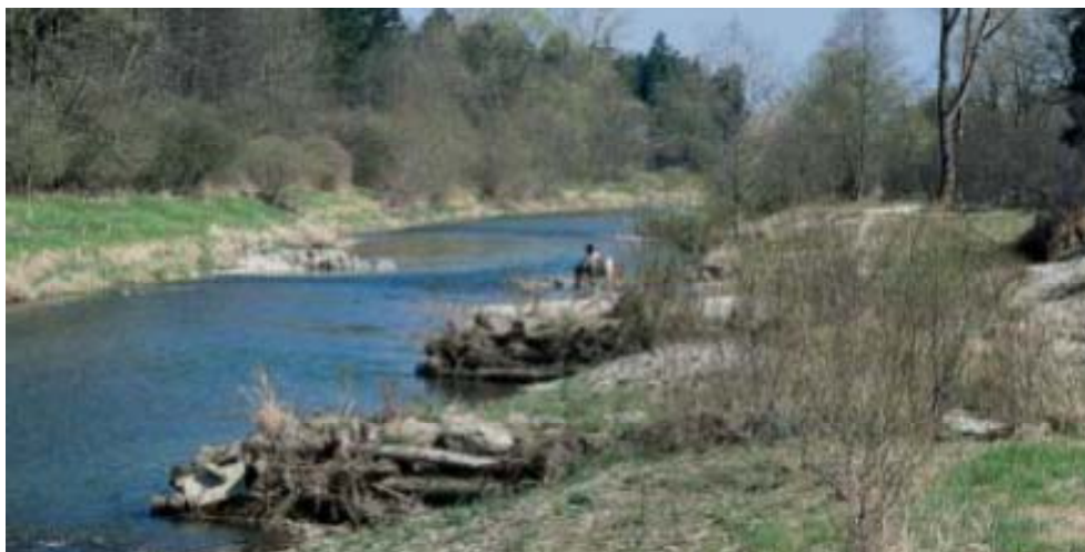
Abbildung 6-15: Beispiel für den Einbau von mit Steinen beschwerten Altholz-Buhnen zur Schaffung zusätzlicher Fischhabitate und zur Förderung der Schwemmholzverkläusung.
