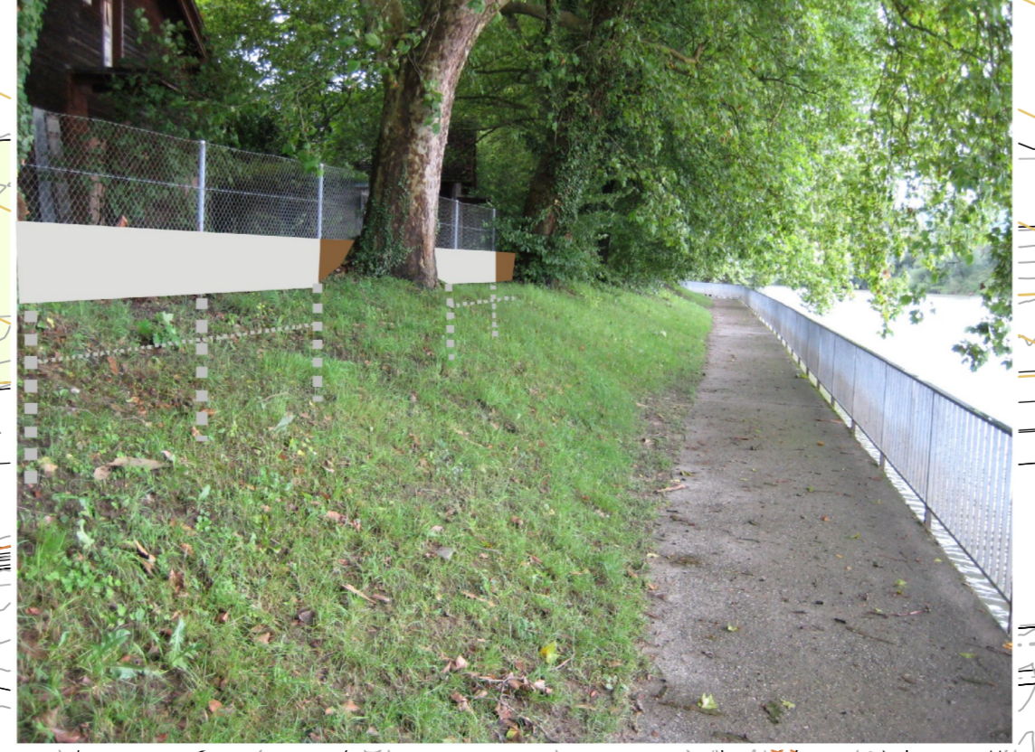
Hochwasserschutzmauer aus Beton, im Nahbereich von Bäumen Lagerung mit Punktfundamenten
