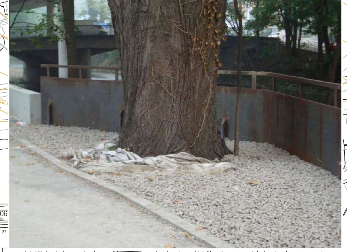
Hochwasserschutzmauer mit Stahlplatten (lokal um Bäume), Lagerung mit Punktfundamenten
