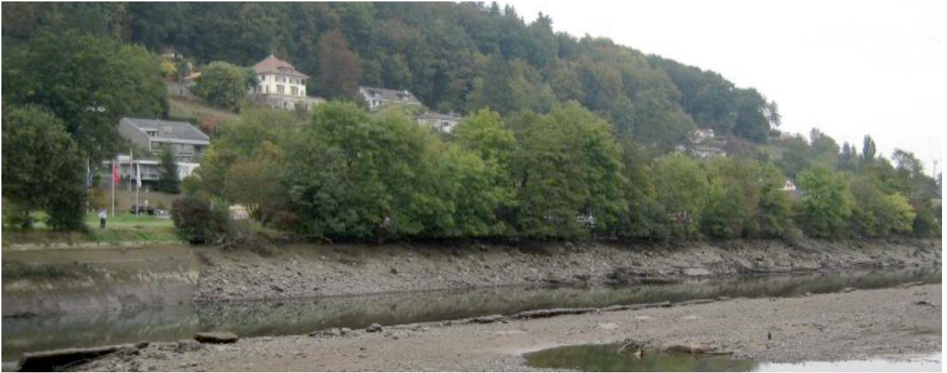
Ansicht heutiges Ufer an der alten Badi (bei Kanalabschaltung, Kanal ohne Wasser).
