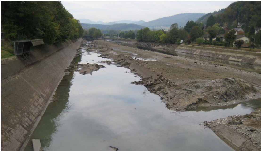
Abb. 4.12: Ungenügend rückgebauter Mitteldamm (Kanalentleerung Okt. 2009).
