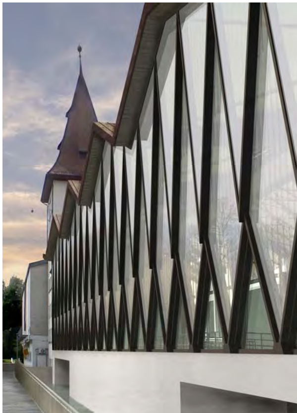
BLICK VON DER UNTERWASSERBRÜCKE
