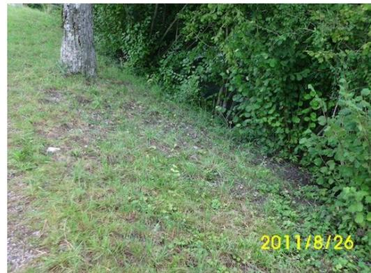
Abbildung 6.8.6: Bereich der vorgesehenen Dammverkürzung: links ist die Nordböschung gegen OW-Kanal 2, rechts die Südböschung gegen OW-Kanal 1. Während im ersten Fall in einem ca. 3.5 m breiten Streifen ziemlich flachgründige bis mässig tiefgründige Böden festgestellt werden konnten, ist die Südböschung stark bewachsen, steil abfallend sowie mit einer meist nur sehr geringmächtigen humosen Auflage über Kies.
