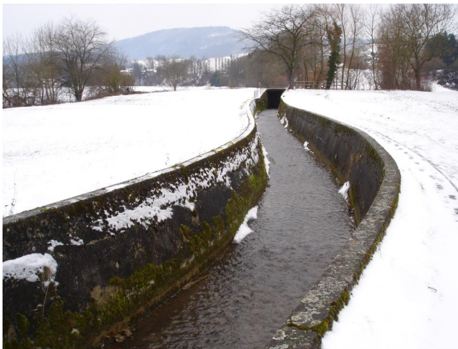
Abbildung 22: Erzbach verläuft auf den untersten 180 m in einem steilen Beton-Trapezprofil. Am oberen Ende, Mitte Bild oben, ist der Ausfluss aus dem Weiher erkennbar.
