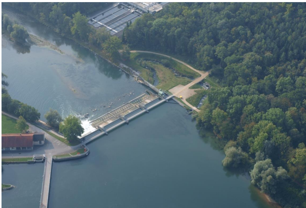
Abbildung 2.2.1: Wehr Schönenwerd mit Fischpass, Beginn der Restwasserstrecke und der Kanäle des Kraftwerks Aarau, Luftaufnahme 21.09.2009. Im Zentrum das Wehr Schönenwerd mit linkem Wehrfeld, das für den Dotierversuch teilweise geöffnet ist. Vordergrund links: Einlauf in die beiden Kraftwerkkanäle. Links von der Brücke: Einlauf zur linksufrigen Dotierturbine. Rechts neben dem Wehr: Raugerinne-Beckenpass (Fischaufstiegshilfe). Beim Wehr: Dotierturbine. Im Hintergrund: ARA Schönenwerd.
