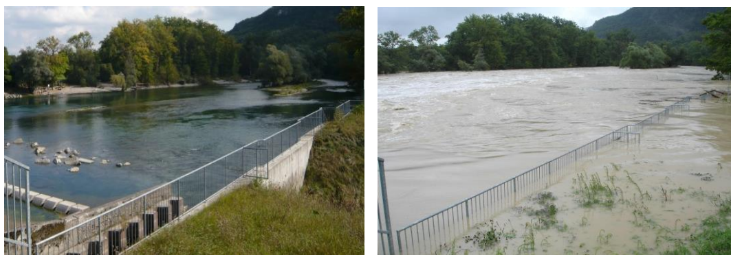
Abbildung 4.1.4: Unterschiedliche Abflussmengen in der Restwasserstrecke unterhalb des Dotierwehrs. Links: Dotierwassermenge 10 m 3 /s, rechts: Hochwasser 2007.
