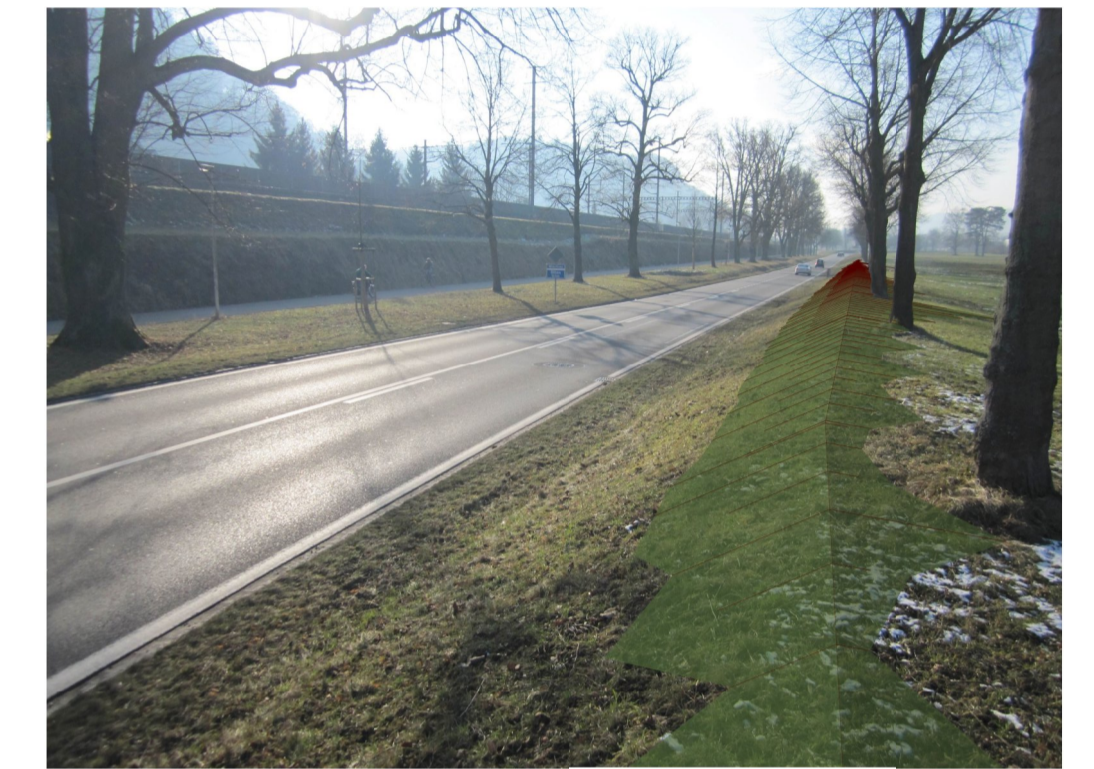
Damm entlang Schachenstrasse (Blickrichtung Westen)
