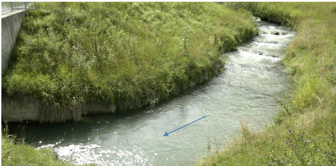
Abbildung 2: Erhalt des heutigen, gut funktionierenden rechtsufrigen Raugerinne-Beckenpasses beim Wehr, Anpassung Mündung best. Raugerinne-Beckenpass (F2). (IUB 2011)
