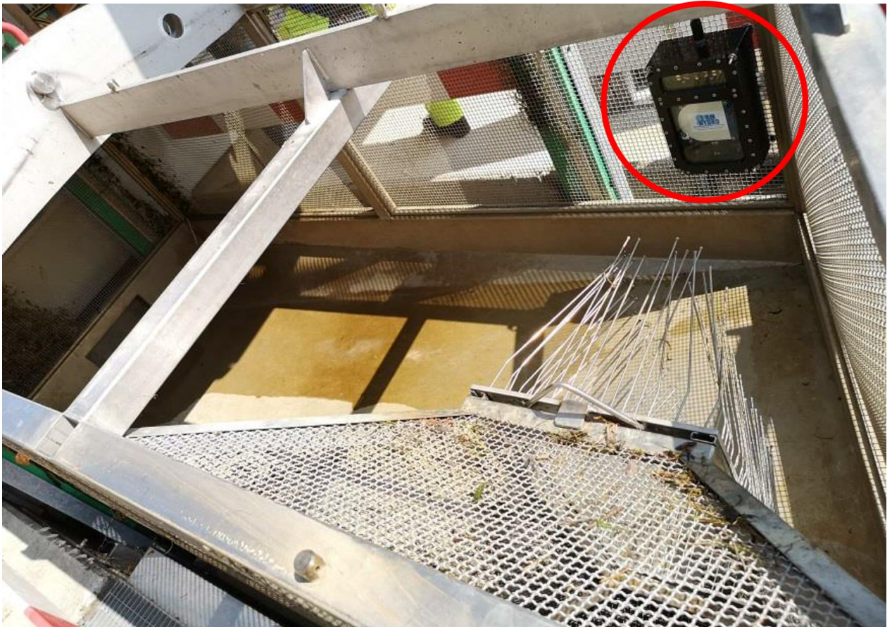
Abb. 5.11 Installierte Unterwasserkamera in der Zählreuse der Kraftwerk Eglisau-Glattfelden AG. Ermöglicht variable Beobachtungsmöglichkeiten von Fischen in einer FAH [Axpö].
