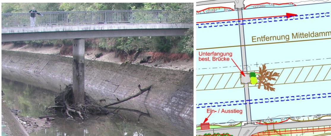
Abb. 29 Kanalabsenkung 2009 mit Geschwemmsel am Brückenpfeiler (links); im Hinterwasser der Brückenpfeiler der zwei Fussgängerbrücken werden auf der strömungsabgewandte Seite Fischunterstände mit Sturzbäumen angelegt (rechts)
