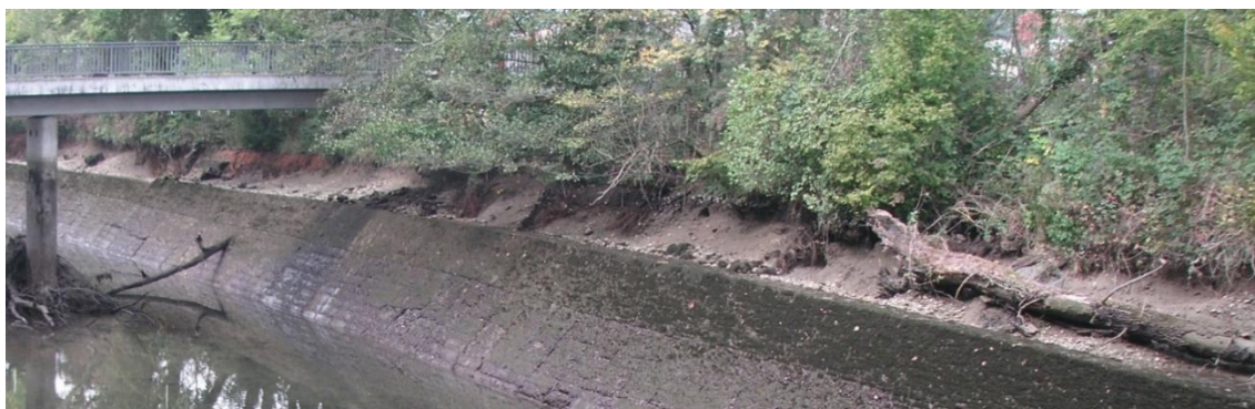
Abb. 28 Die Mauern des Mitteldammes am rechten Ufer reichen nicht bis hinauf zur Wasserlinie. Der oberste Teil des Ufers ist unverbaut und durch Wurzelballen und Holz strukturiert (Foto 6.10.2009, Eniwa).
