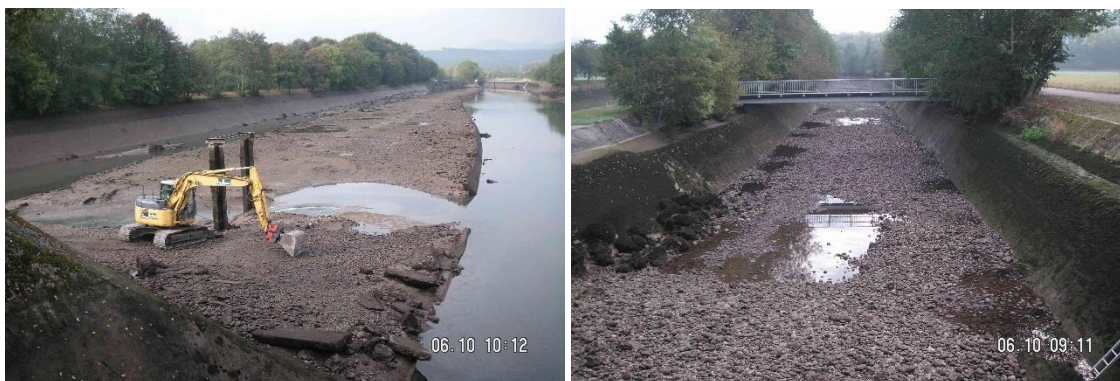
Abb. 27 Kanalabsenkung 2009 (Fotos: Eniwa AG)
