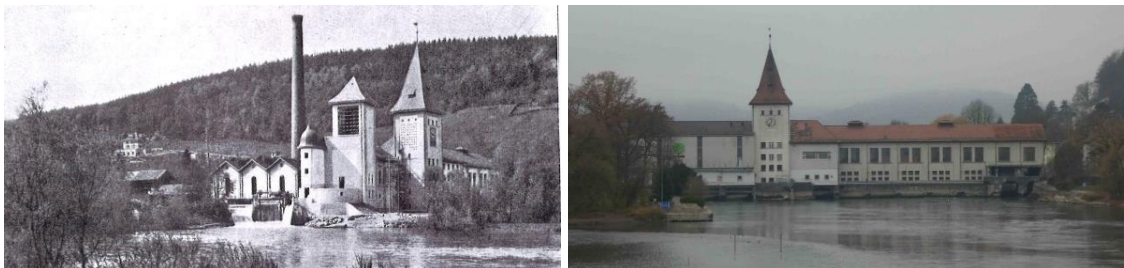
Abb. 49 Hochkamin der thermischen Zentrale, weiterer Turm, Schaltzentralenturm 1913 (links); Ehemaliger Schaltzentralenturm heute (rechts)
