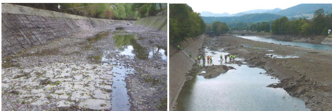
Abb. 45 Kanalentleerung 2009; Kanal 1 (links) und Hauptkanal (rechts) (Fotos: H. Keller 2014)
