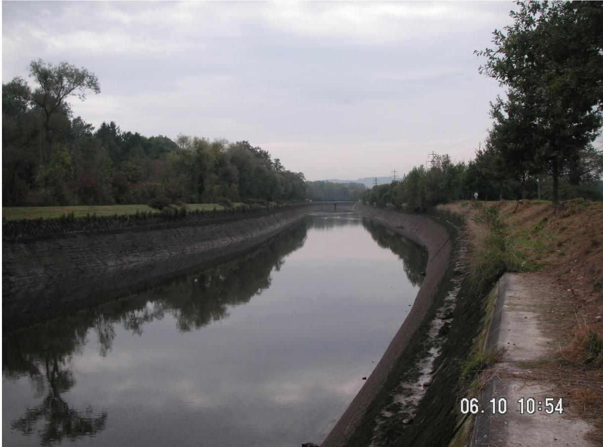
**Abb. 2 Nord-Kanal bei Wasserabsenkung. Die Betonverbauungen reichen mit wenigen Ausnahmen bis über die Wasserlinie. Links im Bild: Südufer (Mitteldamm), rechts im Bild: Nordufer Nord-Kanal. Bäume wachsen nur an wenigen Stellen, haben aber keinen Einfluss auf das Gewässer. Foto vom 6.10.2009: Sigmaphan AG.**
