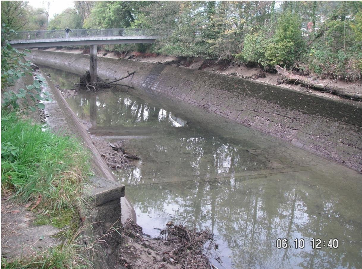
**Abb. 3 Süd-Kanal, Mauern des Mitteldammes (rechts im Bild) reichen nicht bis hinauf zur Wasserlinie. Der oberste Teil des Ufers ist unverbaut und durch Wurzelballen und Holz strukturiert. Foto vom 6.10.2009: Eniwa AG.**
