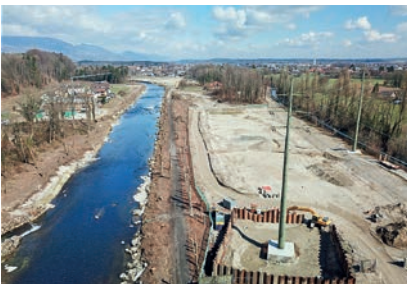
Es braucht viel Planung und Vorarbeit, wie Rodungen und den Bau einer Baupiste, bis der Aushub beginnen kann.
