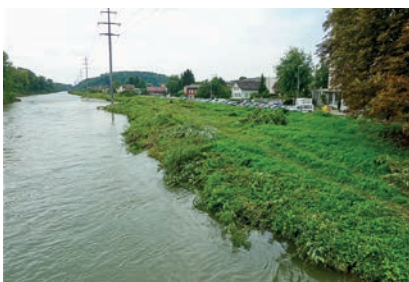
Vor dem Projekt waren die Siedlungen an der Dammstrasse trotz einem Damm ungenügend geschützt.
