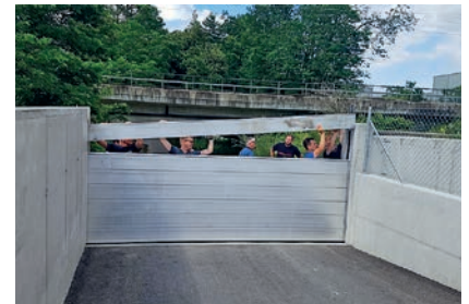
Hochwasserschutzmauern und mobile Elemente schützen die Untere Emmengasse in Luterbach.
