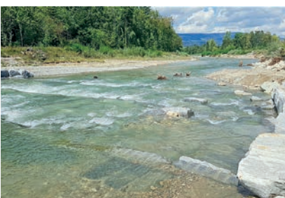
Die neue Riegel-Becken-Rampe stellt den Fischaufstieg sicher.
