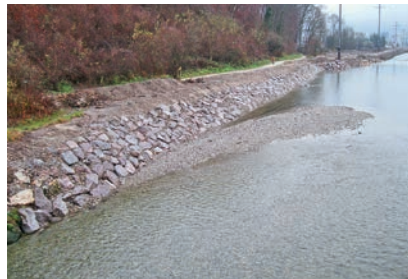
Wo notwendig wurde das Ufer durch Blocksatz vor Erosion geschützt.
