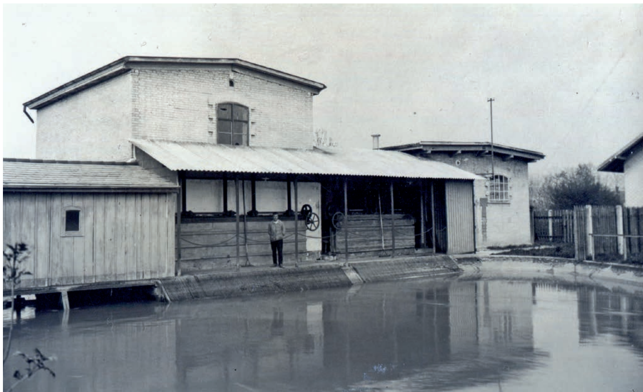
Kraftwerk der Kammgarnspinnerei Derendingen in Luterbach (1988).
