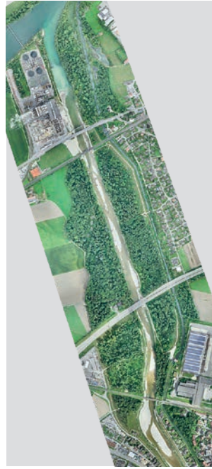
Unverbaute Ufer ermöglichen Eigendynamik (2022).
