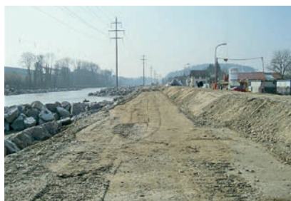
Der alte Damm wird verbreitert und erhöht. Der neue Damm entsteht.
