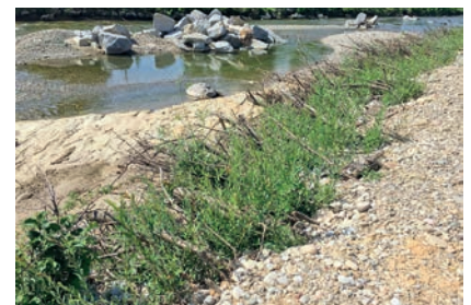
Weidenstecklinge lassen das Ufer in Kürze grün werden.
