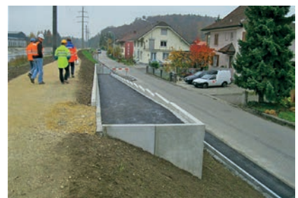
Der neue Damm wird am Schluss begrünt und mit einem breiten Fussweg versehen.
