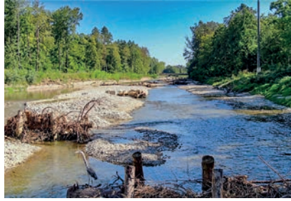
Eingebaute Sohlenstrukturen schaffen gute Verhältnisse für Fische.
