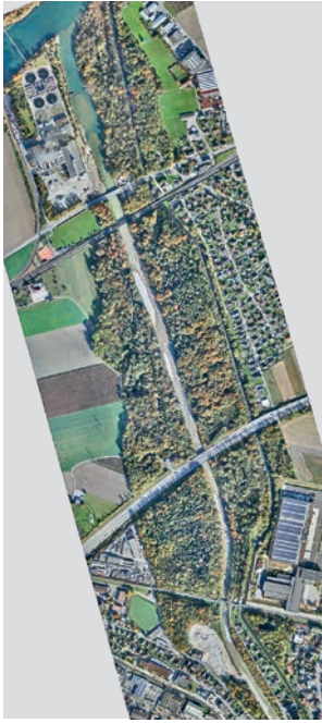
Kanalisiertes Gerinne vor Baubeginn (2017).
