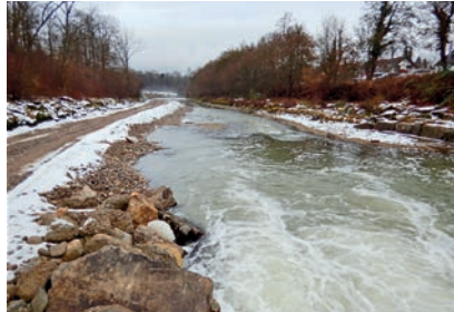
Die ausgehobenen Abfälle werden über eine Baupiste in der Emme abtransportiert.
