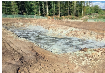
Der abgelagerte Klärschlamm wird sorgfältig ausgehoben und fachgerecht entsorgt.
