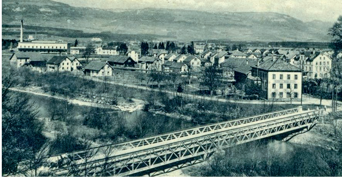
Alte Brücke Derendingen (1940).
