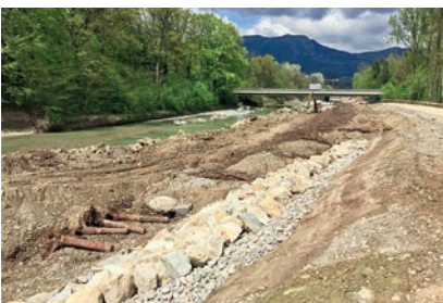
Auf weiten Strecken wurde der Blocksatz mit Totholz und Weidenstecklingen «be-grünt».
