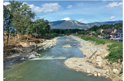
Nach der Deponiesanierung: Grosse Maschinen verändern das Gesicht der Emme.
