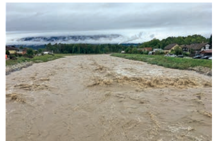
Bei Hochwasser kann die Emme über die ganze Breite abfliessen ohne über die Ufer zu treten (2020).
