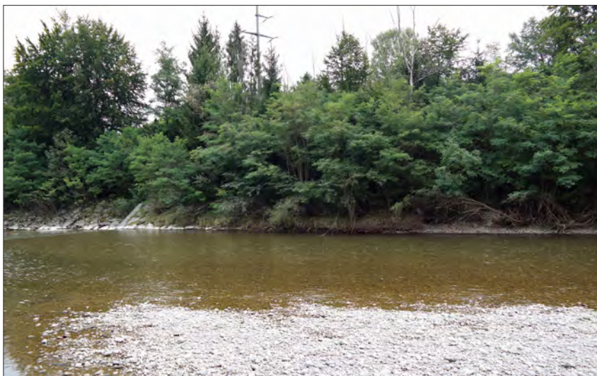
Abb. 11 Fotostandort EC2. Geplante Aufweitung. Links: 25.8.2014 / Rechts: 5.5.2015
