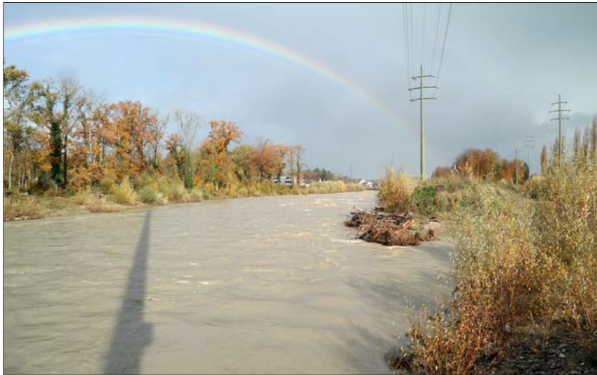
Abb. 22 Fotostandort PF 1 bei Hochwasserabfluss am 15.11.2023. Blick flussabwärts in die aufgeweitete Strecke der Emme, bei welcher der Mast bei Hochwasser auf einer Insel zu liegen kommt.
