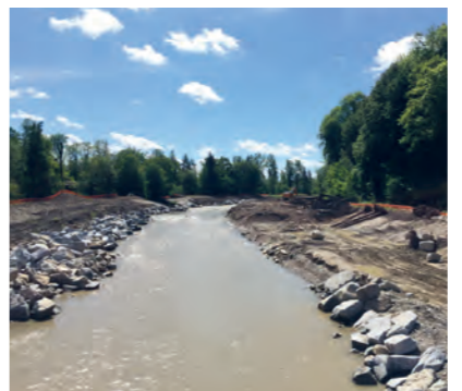
Bauphase am Dittberg
