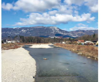
Viel Raum im Bereich der ehemaligen Deponie Rüti nördlich der Strassenbrücke Zuchwil-Derendingen
