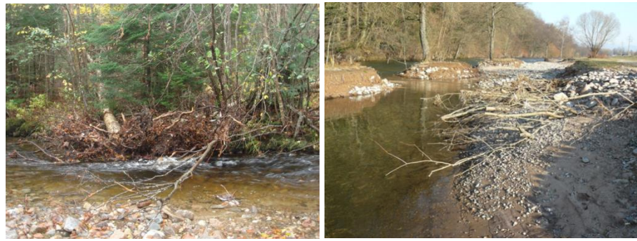
Abbildung 27 Beispiele für mit Totholz (links) und ausschlagfähigen Weidenästen (rechts) strukturierte Ufer
