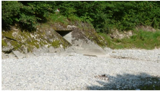
Abbildung 13 Beispiel künstliches Einlaufbauwerk, km 1.630
