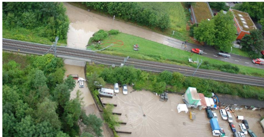
Abbildung 1 Hochwasser 2007, SBB-Unterführung Derendingen, Quelle: AfU
