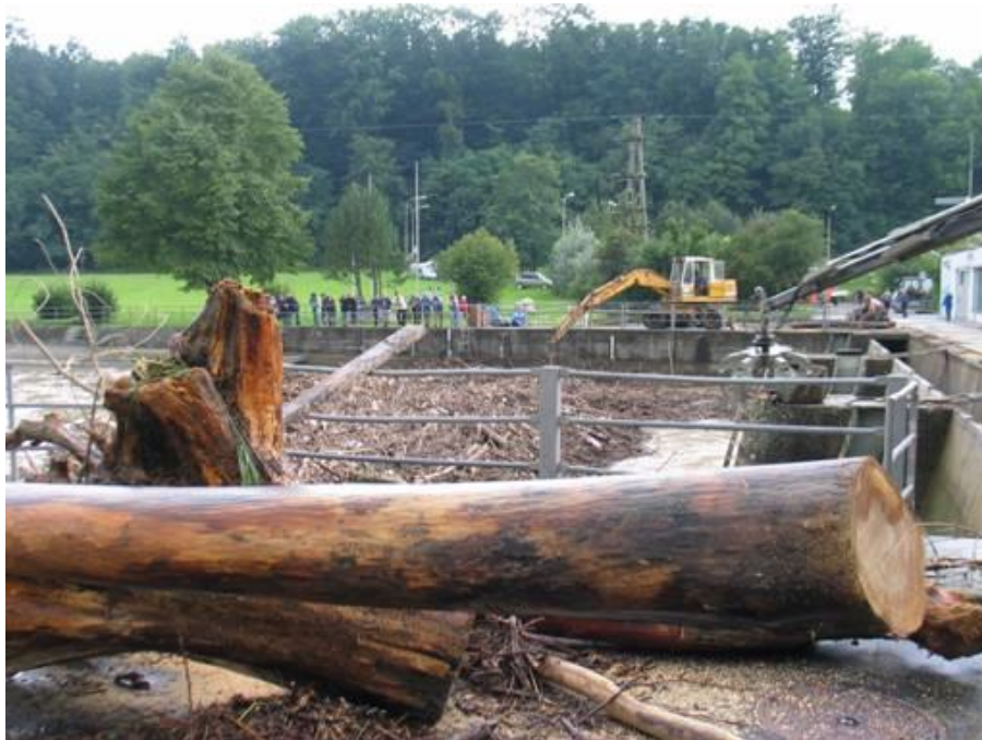
Abbildung 18 Schwemholzansammlung beim Kraftwerk Flumenthal beim Hochwasser 2005.
