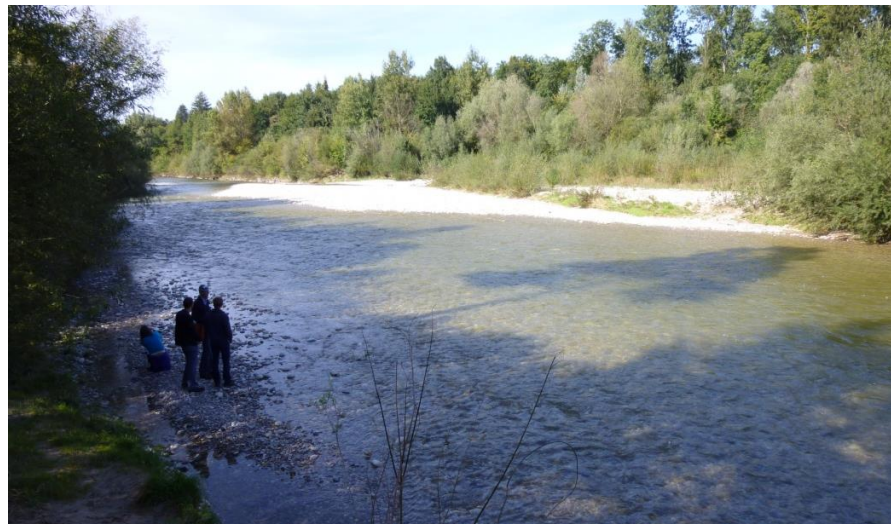
Abbildung 60 Beispiel eines aufgeweiteten Gerinnes an der Emme bei Utzenstorf, sogenannte Emme-Birne, Blick flussabwärts.
