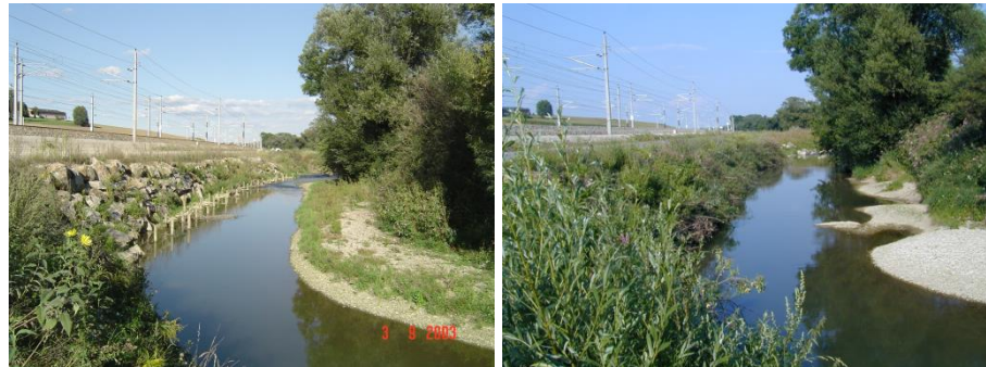
Abbildung 25 Begrünung von Blocksatz mit BMU, links: Blocksatz zum Schutz einer Eisenbahntrasse [4,6], rechts: begrünter Blocksatz ein Jahr nach der Herstellung der BMU
