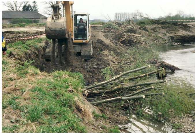
Abbildung 23 Herstellung einer BMU: Maschinelles Einlegen von bewurzelten Gehölzen und Totholz [46]
