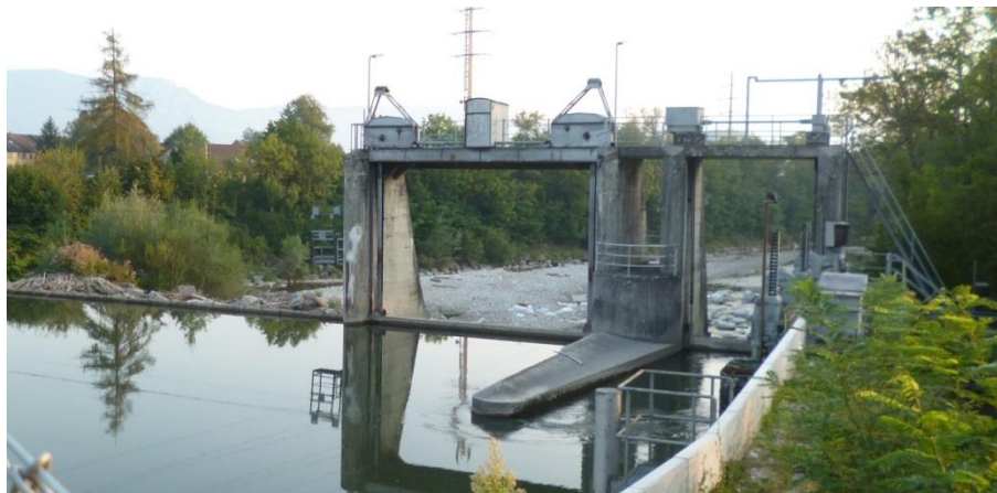
Abbildung 10 Wehr Biberist bei km 4.812
