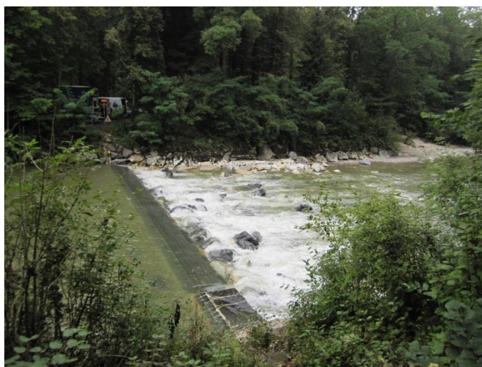
Abbildung 47 Schwelle bei km 3.330
