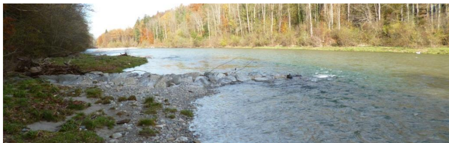
Abbildung 56 Beispiel Blockbuhne, Emme Winterseyschache
