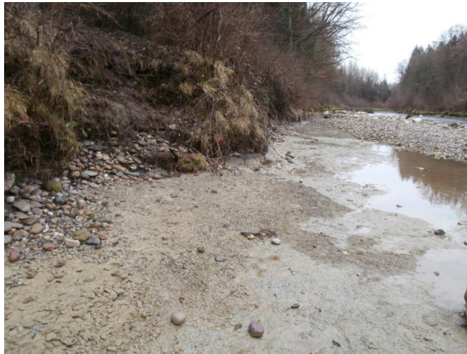
Abbildung 51 Ist-Zustand des rechten Ufers im Bereich M17
