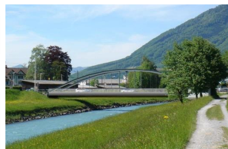
Abbildung 36 Prinzipskizze der Verschalung ("Schürze") für die Hochwasserdurchleitung bei Brücken (links); Beispiel Brückenverschalung: Molliserbrücke / Escherkanal (rechts)
