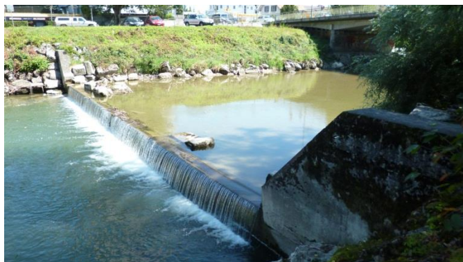
Abbildung 15 Schwelle unterhalb der Brücke Derendingen – Zuchwil, km 2.285
