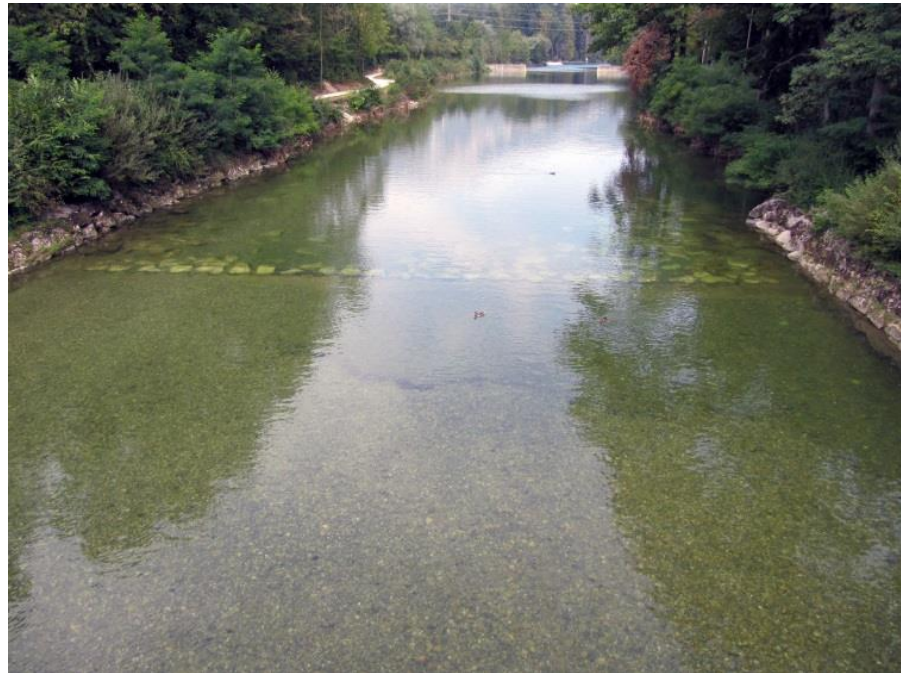
Abbildung 11 Spundwandschwelle (km 0.547) bei vollem Kiessammler und Rückstau aus der Aare
