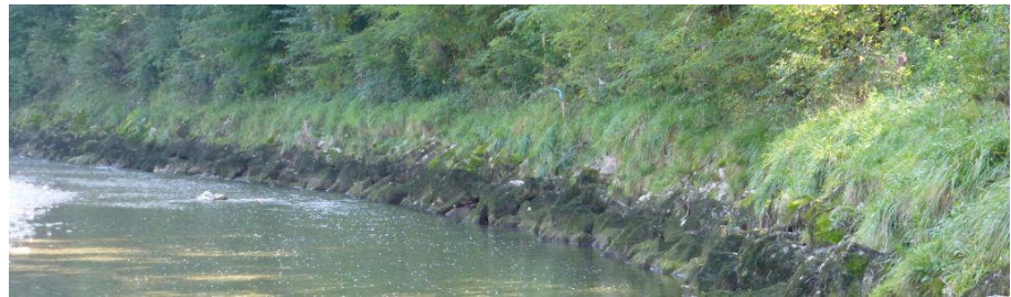
Abbildung 18 Typische Gestalt der Uferböschung: Blocksteine
