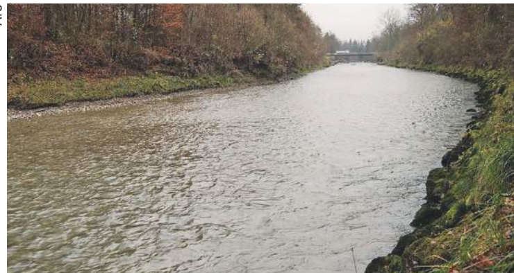
Blick flussaufwärts auf den Abschnitt zwischen Luterbach und Derendingen (auf der linken Bildseite) und Zuchwil (auf der rechten Bildseite): Vor der Sanierung floss die Emme hier in einem engen, wenig strukturierten und begradigten Lauf, der mehr Kanal als Flussbett war.
