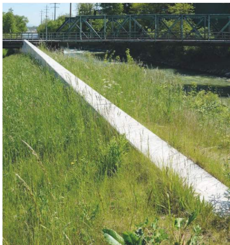
Unterhalb des Wehrs Biberist sind die Platzverhältnisse beidseits der Emme zusehends beengt. Der breitere Schutzdamm geht deshalb im Bereich der BLS-Brücke in eine Hochwasser-Schutzmauer über, die sich über eine Länge von rund 80 m erstreckt (Foto oben).
