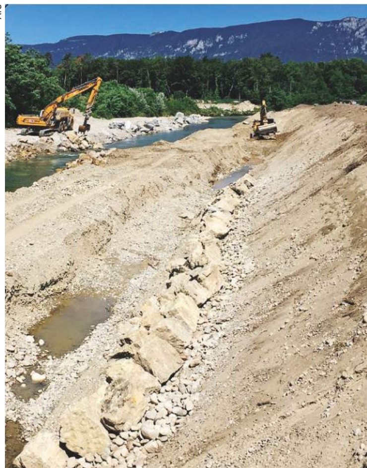
Erneuerung des rechtsufrigen Uferschutzes entlang der Unteren Emmengasse, die von Derendingen aus über die Gemeindegrenze bis nach Luterbach führt.
