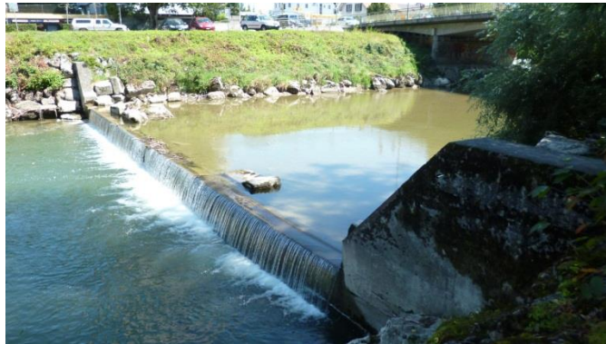
Abbildung 15 Schwelle unterhalb der Brücke Derendingen – Zuchwil, km 2.285
