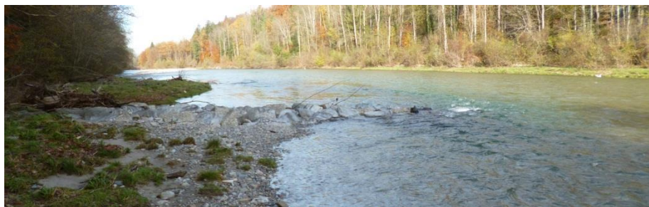
Abbildung 56 Beispiel Blockbuhne, Emme Winterseyschache
