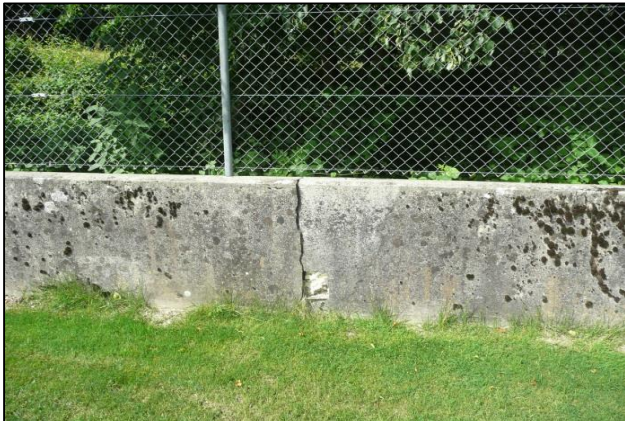
Mauer am östlichen Feldrand teilweise defekt
