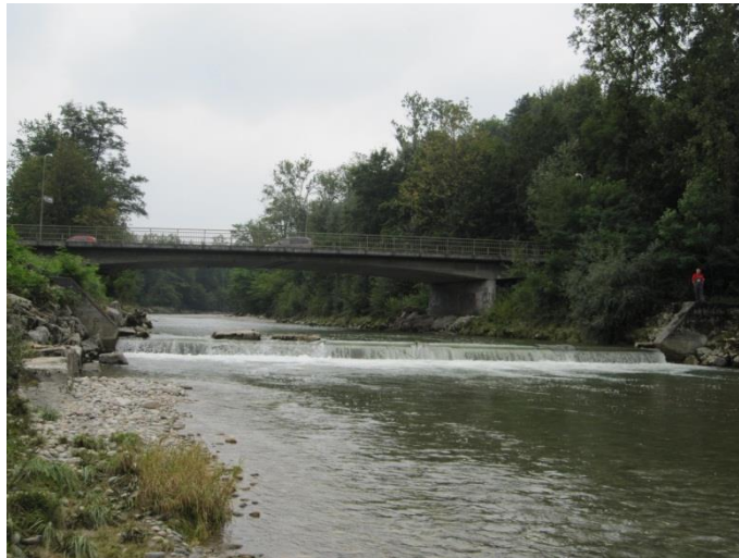
Abbildung 53 Unterwasseransicht der Derendinger Brücke unterhalb liegende Schwelle (Bereich M19)
