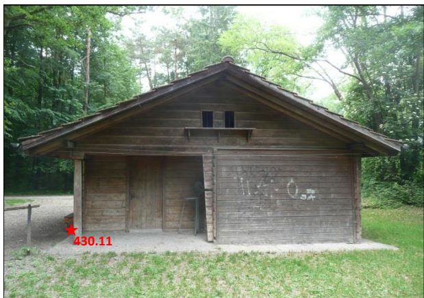
Heim Nord (klein), Südfassade
