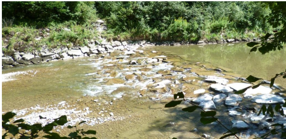
Abbildung 54 Blockrampe km 1.674
