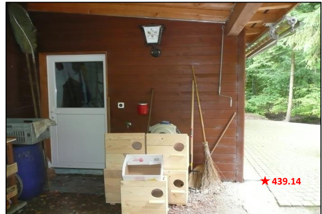
Nordeingang Vereinsraum / Verpflegungsraum
