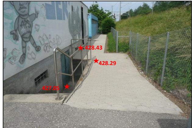
Süd-/ Bahndammseite der Clubhäuser
