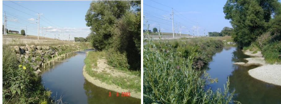
Abbildung 25 Begrünung von Blocksatz mit BMU, links: Blocksatz zum Schutz einer Eisenbahntrasse [44], rechts: begrünter Blocksatz ein Jahr nach der Herstellung der BMU
