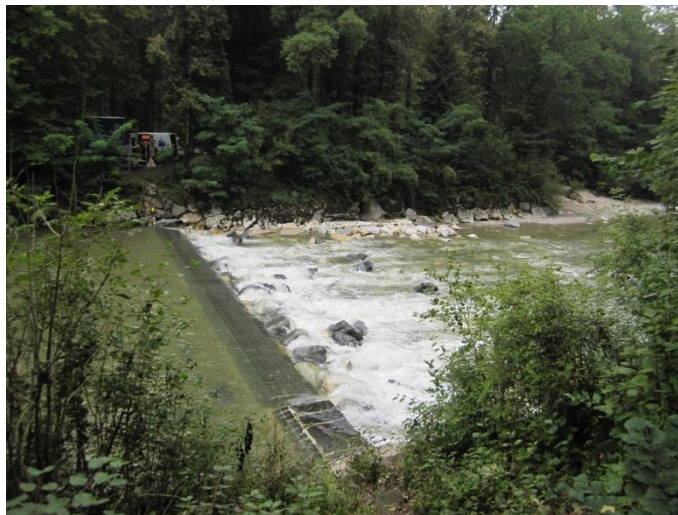
Abbildung 47 Schwelle bei km 3.330
