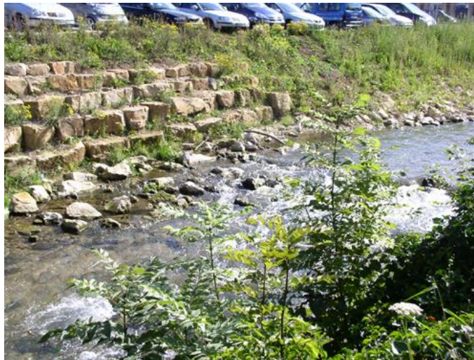
Abbildung 44 Als Sitzstufen gestalteter Blocksatz (Beispiel)
