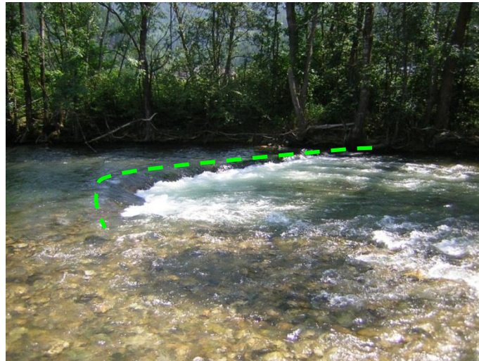
Abbildung 31 Hakenlenkbuhne in der Mürz / Steiermark
