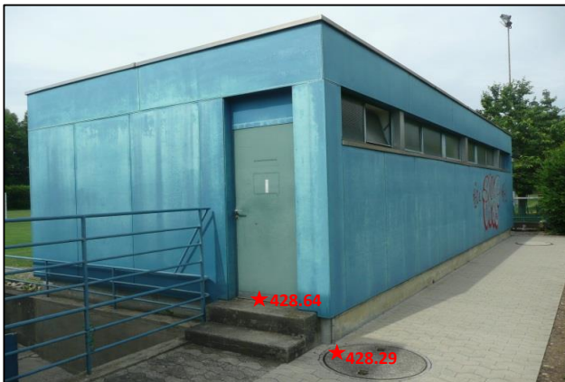
Westseite blaues Clubhaus (Umkleidekabinen)
