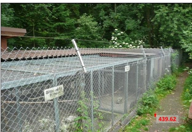
Fusspfad entlang Dammfuss Kanaldamm
