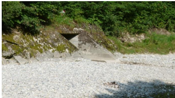
Abbildung 13 Beispiel künstliches Einlaufbauwerk, km 1.630
