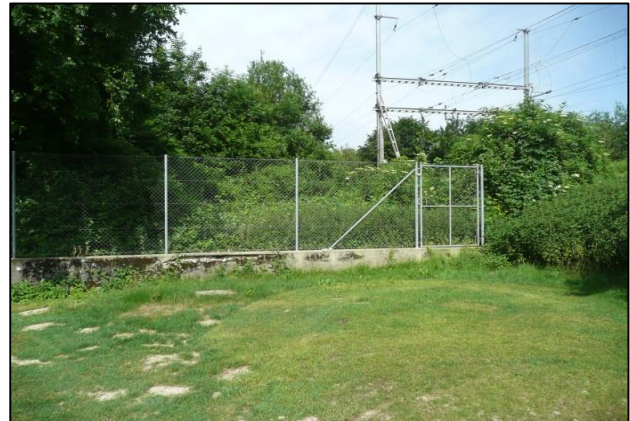
Südliches Ende der Mauer
