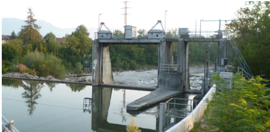
Abbildung 10 Wehr Biberist bei km 4.812
