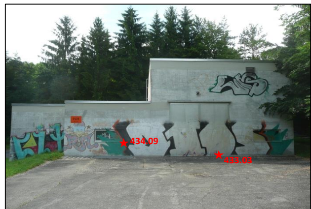
Südfassade Pumpwerk 105 Autobahn A5
