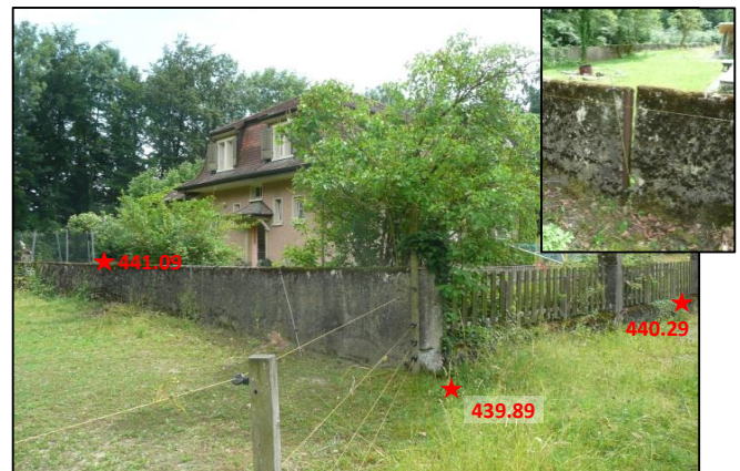
Mauer Nord, teilweise defekt
