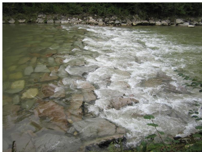
Abbildung 46 Blocksteinrampe bei km 3.934
