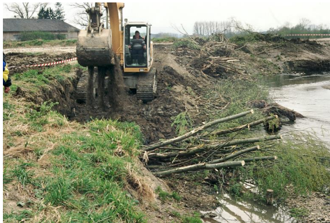
Abbildung 23 Herstellung einer BMU: Maschinelles Einlegen von bewurzelten Gehölzen und Totholz [44]
